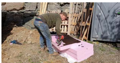
Jörg streicht die XPS-Platten dick mit Dobau-2K-Bitumendickbeschichtung ein ...
