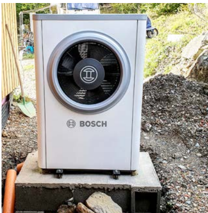
Die Außeneinheit der Wärmepumpe
