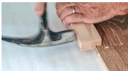
Das Schlagholz sollte flächig aufliegen und nicht verkanten. Niemals auf der Feder auflegen oder mit dem Hammer auf die Feder schlagen!
