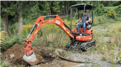
Probebaggerung, um die Tragfähigkeit des aufgeschütteten Plateaus zu beurteilen.
