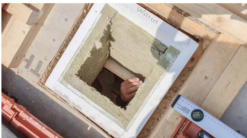
Platzierung der Kamindurchführung im Dachausschnitt zwischen den Dachsparren.
