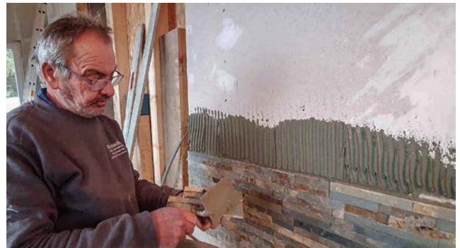
Milan bestreicht nicht nur die Wand mit Flexkleber, sondern auch die Rückseiten der Natursteinverblender.
