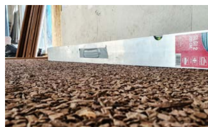
So soll das Ergebnis aussehen: die Wasserwaage genau auf Oberkante des Schüttniveaus und keine Hohlräume oder Buckel in der Schüttung.
