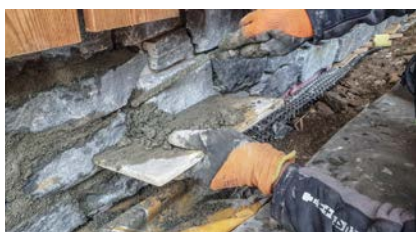
Mit der Fugenkelle wird der Fugenzement in die Ritzen gespachtelt.
