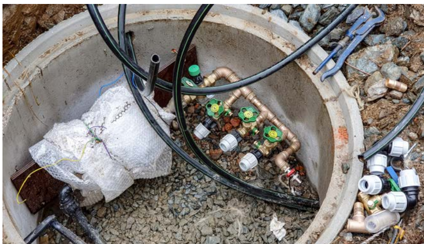
Finale Montage des Wasseranschlusses in einem Wasserschacht
