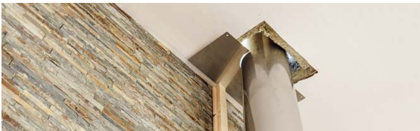
Das vorletzte Segment des Kamins reicht bis zur Dachoberfläche.
