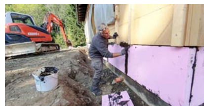
... und ich verklebe sie an der Bodenplatte und verspachtle die Stöße und den Spalt zwischen XPS-Platte und Gebäude-Unterkante.
