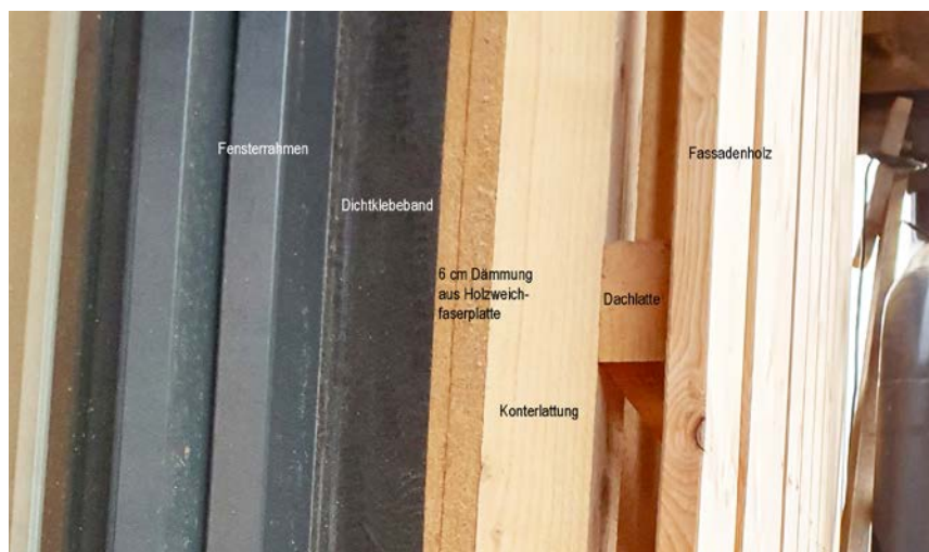
Hier blicken wir hinter die Fassade aus Lärchenböden. Die Fensterlaibung muss nicht nur den Montagespalt überdecken, sondern auch den Hohlraum hinter der Fassade.
