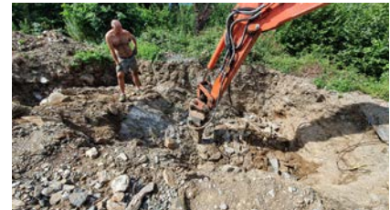
Purer Fels verhindert die Positionierung der Regenwasserzisterne. Wir müssen ausweichen.
