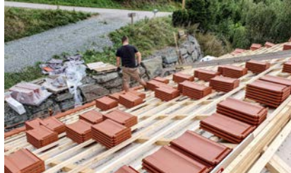
Nur gut, dass wir zwei Helfer haben, die uns die Dachziegel auf dem Dach verteilen.
