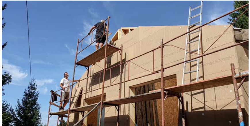
Das Anbringen der Holzweichfaserplatten macht Spaß und es geht zügig voran.
