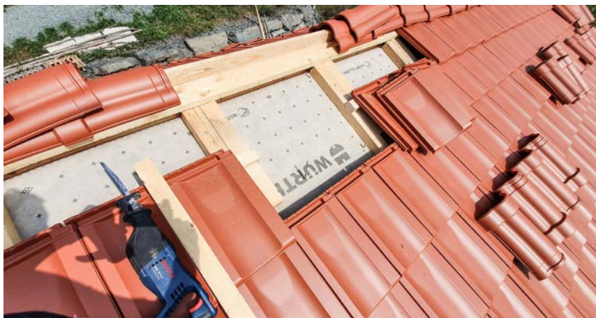
Das Dach muss partiell wieder geöffnet werden, damit die Kamindurchführung eingebaut werden kann.
