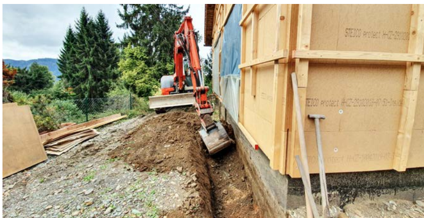
Rund um die Bodenplatte wird ca. einen halben Meter tief aufgegraben.
