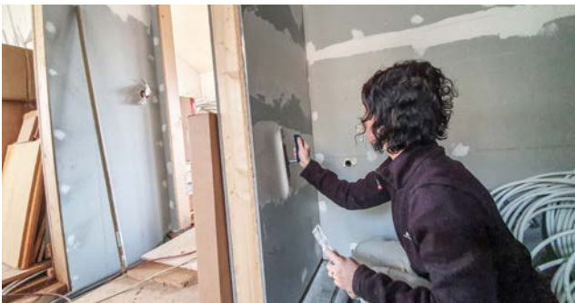
Edith verspachtelt hier gerade die Feuchtraum-fermacell-Platten im Bad.
