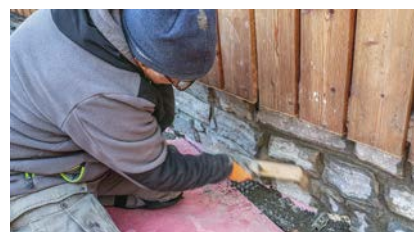
Glätten der Fugen mit einem groben Handfeger oder einer Bürste
