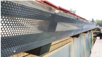
Das Vogelschutzgitter verhindert, dass sich Vögel und kleine Nager unter unserem Dach einnisten.
