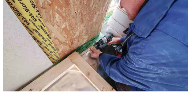
6 × 8 cm Kanthölzer werden zu einem Rahmen an den Wänden verschraubt.
