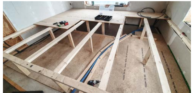
Die Plattform wird mit esb-Plus-Platten belegt.
