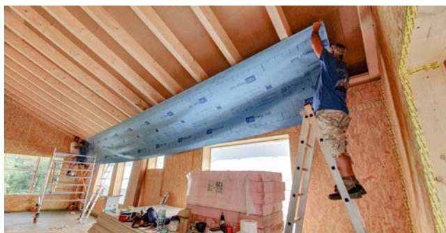
So wird das nix! Die 12-Meter-Bahn ist einfach zu lang.
