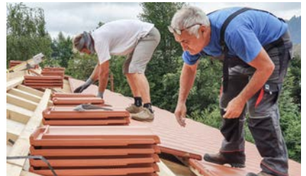
Zu zweit geht das Verlegen der Ziegel ratzfatz. Handschuhe tragen sollte obligatorisch sein, weil die Ziegel teils scharfkantig sind.
