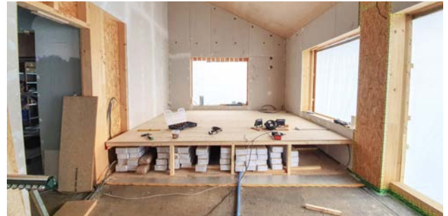
Fertig ist das Podest, unter dem wir zunächst Baumaterial lagern.
