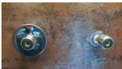
Hier sind die beiden Exzentraufsätze gut zu erkennen.
