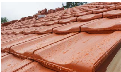
Die Ziegel liegen passgenau ineinander.
