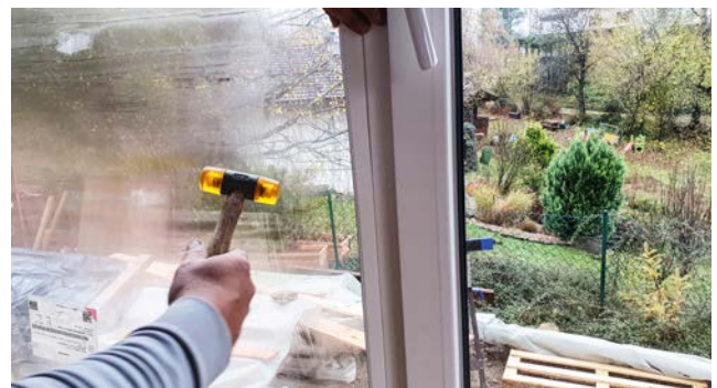
Mit dem Kunststoffhammer werden nun die Rahmenleisten in den Rahmen eingeschlagen.
