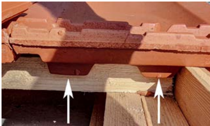
Hier sieht man schön die beiden Nasen an der Unterseite des Ziegels, die an der Dachlatte eingehängt werden.
