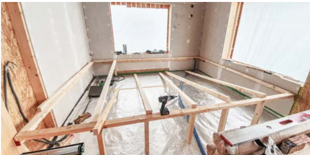
Im Abstand von ca. 60 cm werden Zwischenträger eingezogen.
