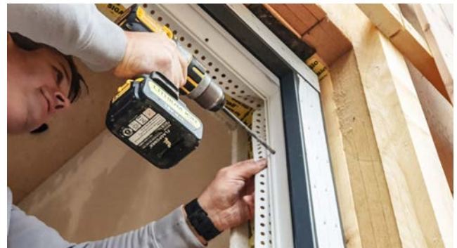
Durch die für die Verschraubung vorgesehenen Löcher im Fensterrahmen wird das Fenster mit der Holzkonstruktion verschraubt.
