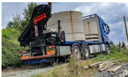
Mit schwerem Gerät werden die Betonringe für Senkgrube, Sickergrube und Zisterne geliefert und auf der Bodenplatte der Garage abgesetzt.
