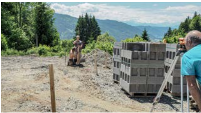
Mit dem Laser-Nivelliergerät werden die Oberkante der Bodenplatte und die Tiefe der Frostschräge festgelegt.
