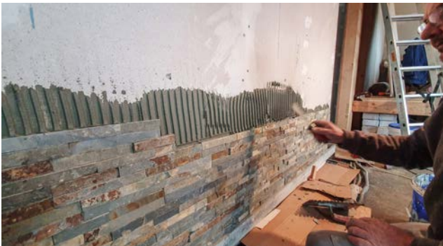
Der Flexkleber wird mit einer groben Zahnpachtel auf die Wand aufgebracht.
