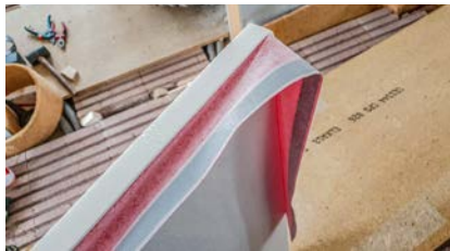
Der überstehende Rand des Dichtbands wird nach dem Einbau mit der Wand verklebt.
