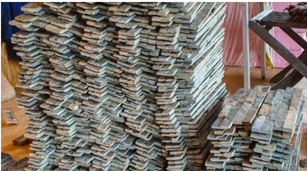
Die Natursteinverblender sollte man farblich sortieren, damit man sie gleichmäßig durchmischen kann.
