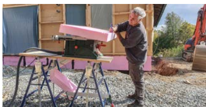
Wo notwendig, werden die Platten mit dem Cuttermesser oder auf der Tischkreissäge zugeschnitten.
