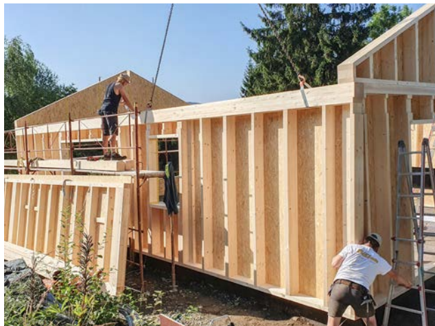
9:24 Uhr: Das letzte Stück Außenwand wird eingesetzt.
