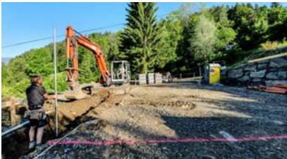
Ausbaggern der Fundamentstreifen und überprüfen der Tiefe mit dem Nivelliergerät
