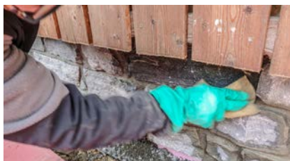
Letzter Schritt: Fugenzement mit feuchtem Schwamm vom Stein wischen
