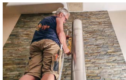
Die zweite Wandhalterung sitzt in der Mitte zwischen der ersten Halterung und der Dachdurchführung.
