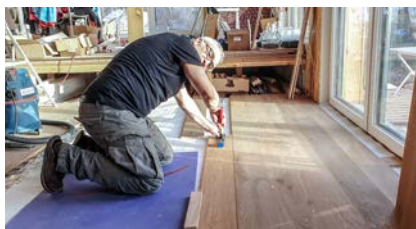
Zunächst werden mit dem Zugeisen die Stirnseiten der Dielen verbunden.
