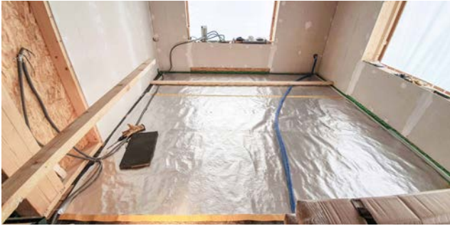
Zunächst wird die UMODAN 3Plus-Folie als Bauwerksabdichtung verlegt.
