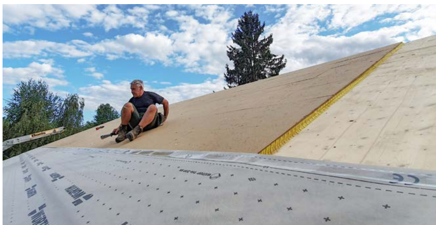
Die Befestigung der Unterspannbahn erfolgt mit einem Schlagtacker.
