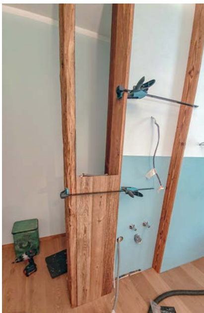
Ein breiter Altholz-Balken bildet den Abschluss.
