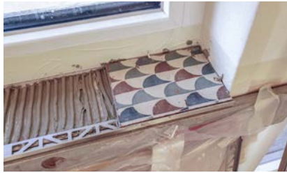
Mit der ersten Fliese wird auch gleich die Edelstahlleiste eingearbeitet.
