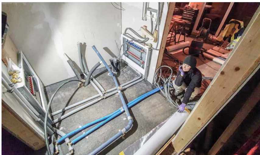
Shit happens! Die Leitungen sind verlegt, aber die Folie leider noch nicht.
