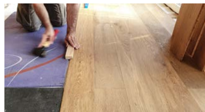
Dann werden die Dielen an der Längsseite mit dem Schlagholz zusammengefügt.
