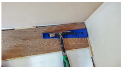
Mit dem Zugeisen werden die Dielen an ihren Stirnseiten zusammengefügt.
