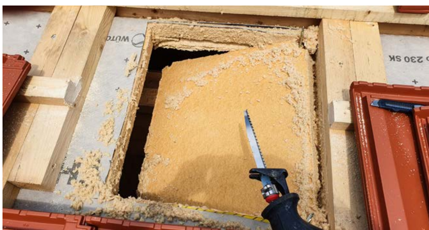
Die Unterspannbahn wird aufgeschnitten und die Holzweichfaserplatte herausgesägt.
