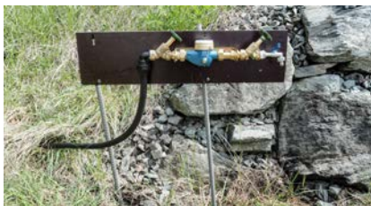
Die provisorische Installation von Wasseruhr und Anschluss während der Bauzeit
