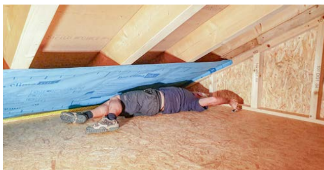
In den tiefsten Winkeln unseres Dachbodens ist das Anbringen der Dampfbremse gar nicht so einfach.
