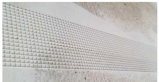
Gewebeband gegen Rissbildung an den Stößen der Wände
