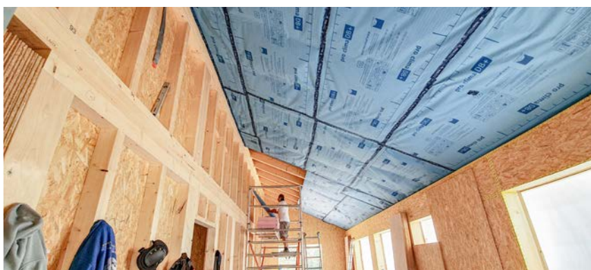
Die Unterspannbahn ist fast fertig montiert.
