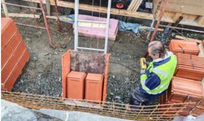
Jetzt gehts los. Charly füttert den Schrägaufzug von Boels.
