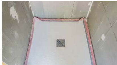
Jetzt sitzt die Duschtasse satt wie eingegossen.
