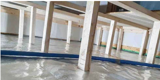
Die Konstruktion muss so stabil sein, dass sie die Lithotherm-Steine, die Möbel und mehrere Personen auf dem Podest tragen kann.
