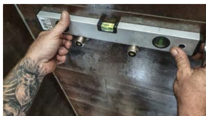
Mit Exzentraufsätzen wird die Duscharmatur waagrecht ausgerichtet.
