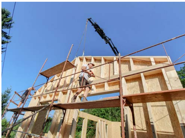
8:57 Uhr: Der obere Teil der Giebelwand wird auf der Südostseite aufgesetzt.
