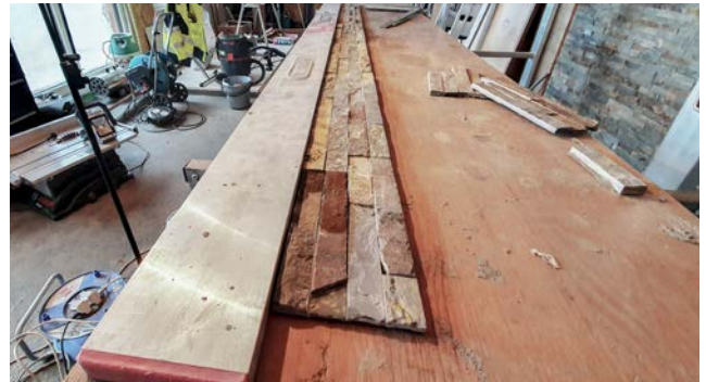
Auslegen der gut durchmischten Natursteinverblender an einer Aluleiste
