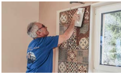
Nach dem Aushärten des Fliesenklebers kann das Fugenmaterial in die Fugen eingearbeitet werden.
