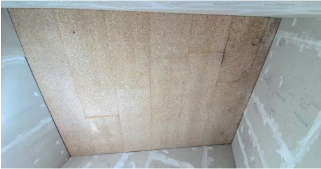
Die esb-Plus-Platten bilden zusammen mit den Schrauben eine aussteifende Scheibe.
