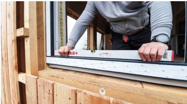
Das Fenster wird sowohl horizontal als auch vertikal mit der Wasserwaage ausgerichtet.
