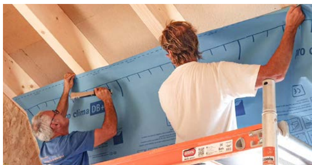
Die Bahn wird parallel zur Wand ausgerichtet und mit dem Schlagtacker auf den Dachsparren fixiert.
