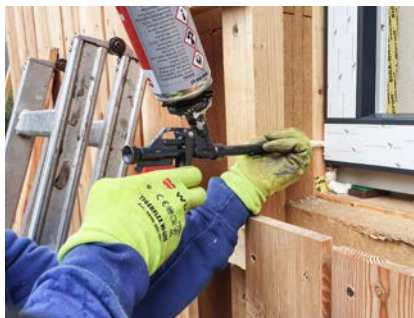
Der vom Fensterbauer ausgeschäumte Spalt zwischen Fenster und Bauwerk muss noch überdämmt werden.
