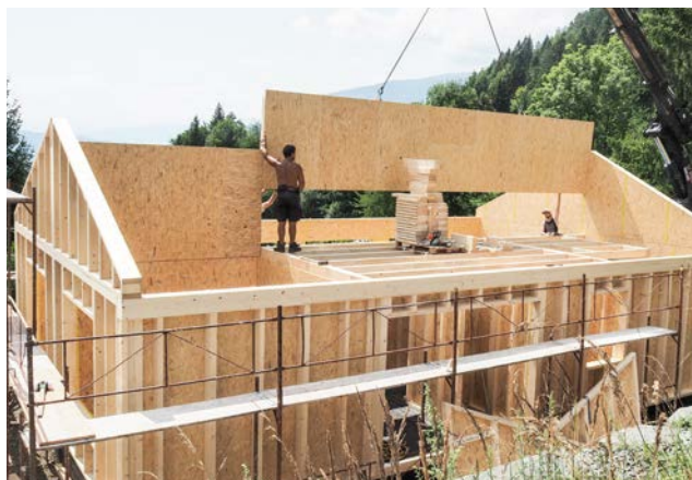
13:32 Uhr: Der Oberteil der Mittelwand wird eingesetzt.
