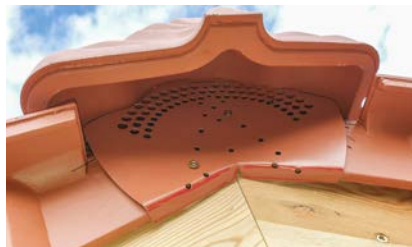
Die beiden Firstendziegel bilden den Abschluss an den Seiten des Dachs.
