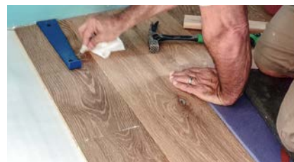
Wo Holzleim austritt, muss dieser gleich mit einem angefeuchteten Papiertuch abgewischt werden.
