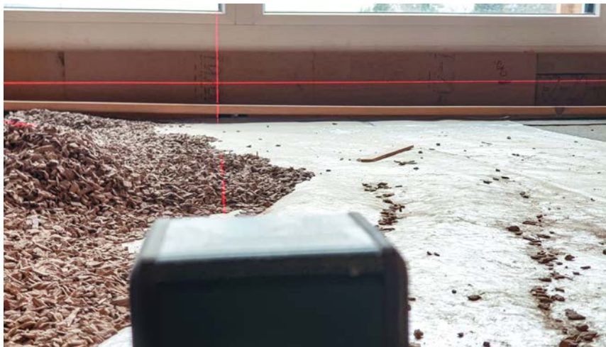
Mit dem Laser-Nivelliergerät wird die Oberkante der Schüttung markiert.
