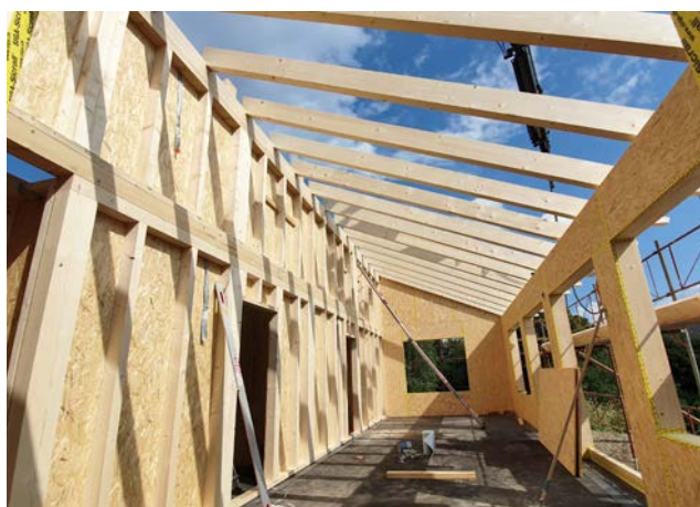
16:15 Uhr: Alle Dachsparren sind montiert.
