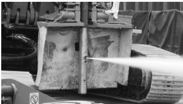
Bild 2. Hochdruckstrahl am Austritt des Düsenstrahlgestänges
