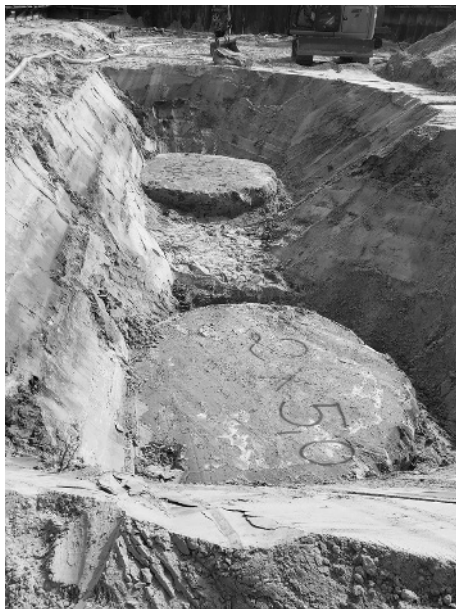
Bild 3. Freigelegte Probesäulen im Düsenstrahlverfahren
