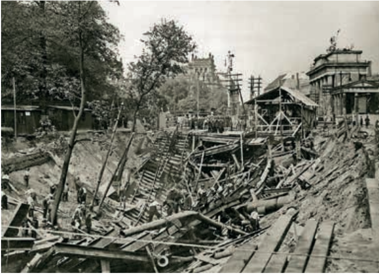
Der Einsturz der Baugrube des Nord-Süd-Tunnels am 20. August 1935 im Bereich kurz vor dem Brandenburger Tor kostete 19 Arbeiter das Leben.
