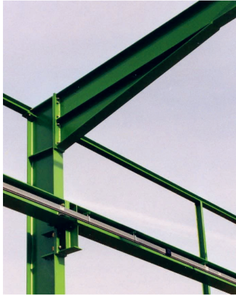
Bild 1.4 Rahmenecke mit Voute und Kranbahnträger
