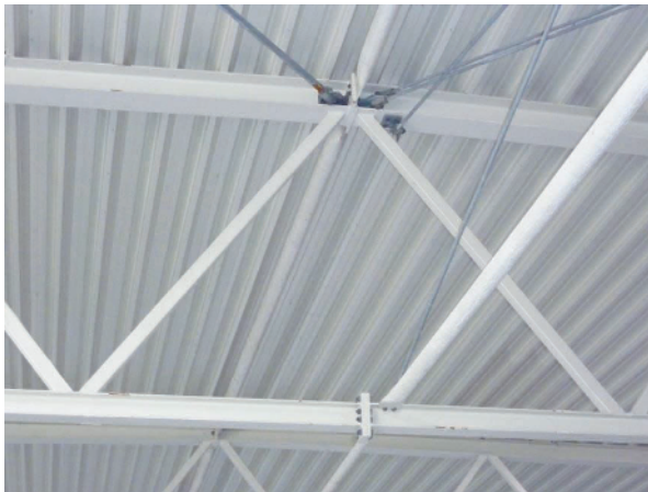
Bild 1.16 Detail Fachwerkbinder mit Stahltrapezblechen
