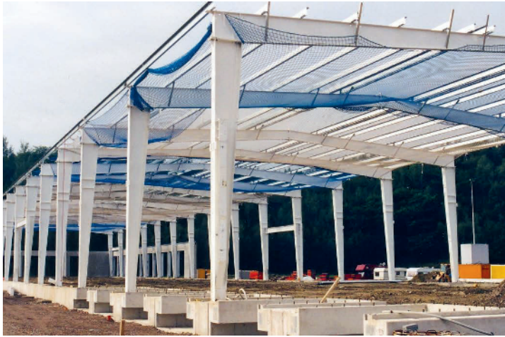
Bild 1.6 Geschweißte Zweigelenrahmen einer Lagerhalle
