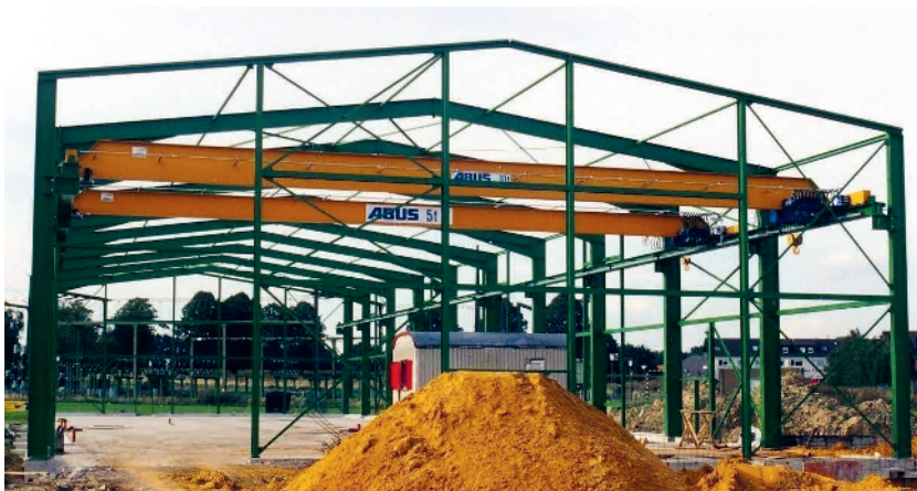
Bild 1.2 Giebelwandkonstruktion
