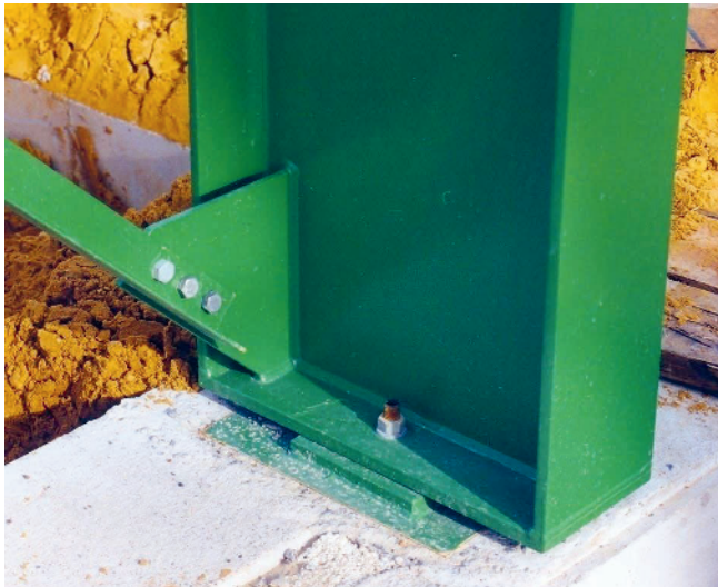
Bild 1.5 Gelenkiger Stützenfuß
