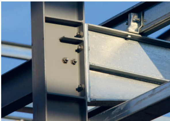
Bild 1.11 Geschraubte Rahmenecke
