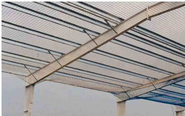
Bild 1.7 Dachpfetten, Schrägstreben und Rahmenriegel
