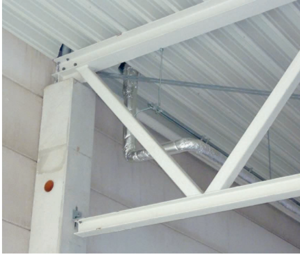
Bild 1.15 Auflagerdetail eines Fachwerkbinders
