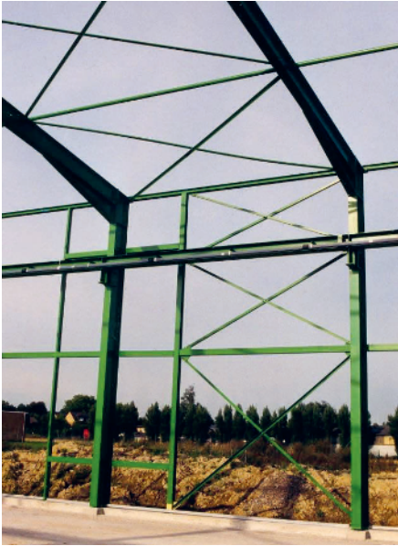
Bild 1.3 Wand- und Dachverband
