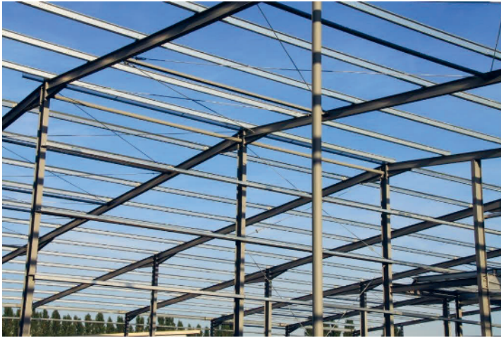
Bild 1.9 Rahmenkonstruktion und Dachpfetten
