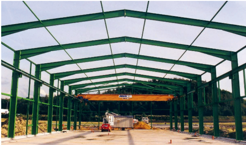
Bild 1.1 Zweigelenkrahmen einer Fertigungshalle aus Walzprofilen
