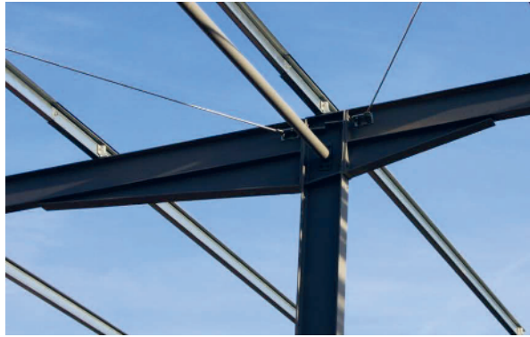
Bild 1.12 Mittelstütze mit Rahmenecken
