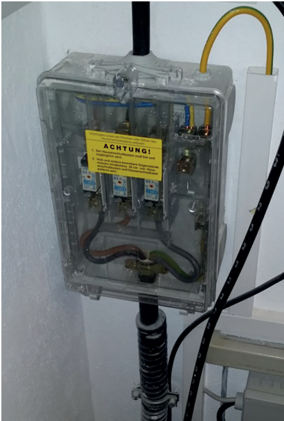
Abbildung 11: Typischer Hausanschlusskasten (HAK) (Quelle: Rudolph Tietzsch GmbH & Co. KG)
