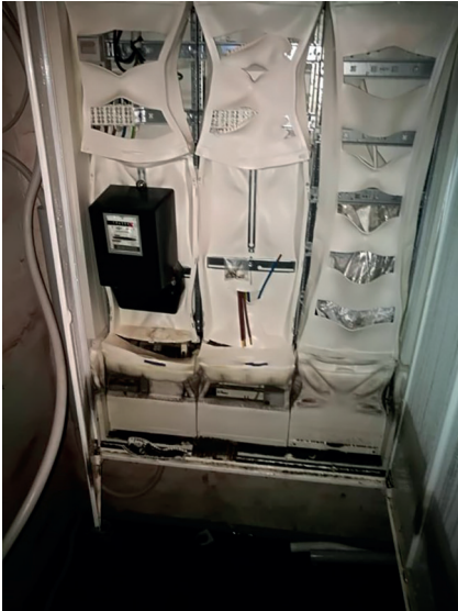
Abbildung 12: Zählerkasten mit Hausanschluss und Verteilung (Quelle: Tobias Visser)
