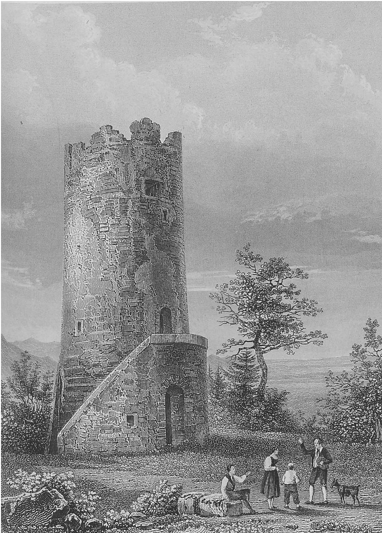
Abb. 1: Ruine der Burg Zähringen. Stahlstich um 1840.
