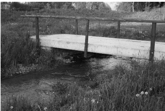
Abbildung 1.21 Brücke: Wo Überquerungen notwendig sind, hält eine Brücke Wasserbett, Ufer und Luftraum frei, hindert folglich die Wanderbewegungen weit weniger als die Verrohrung. Bei einfacher Bauweise (s. Foto) kann sie sogar preiswerter sein.
