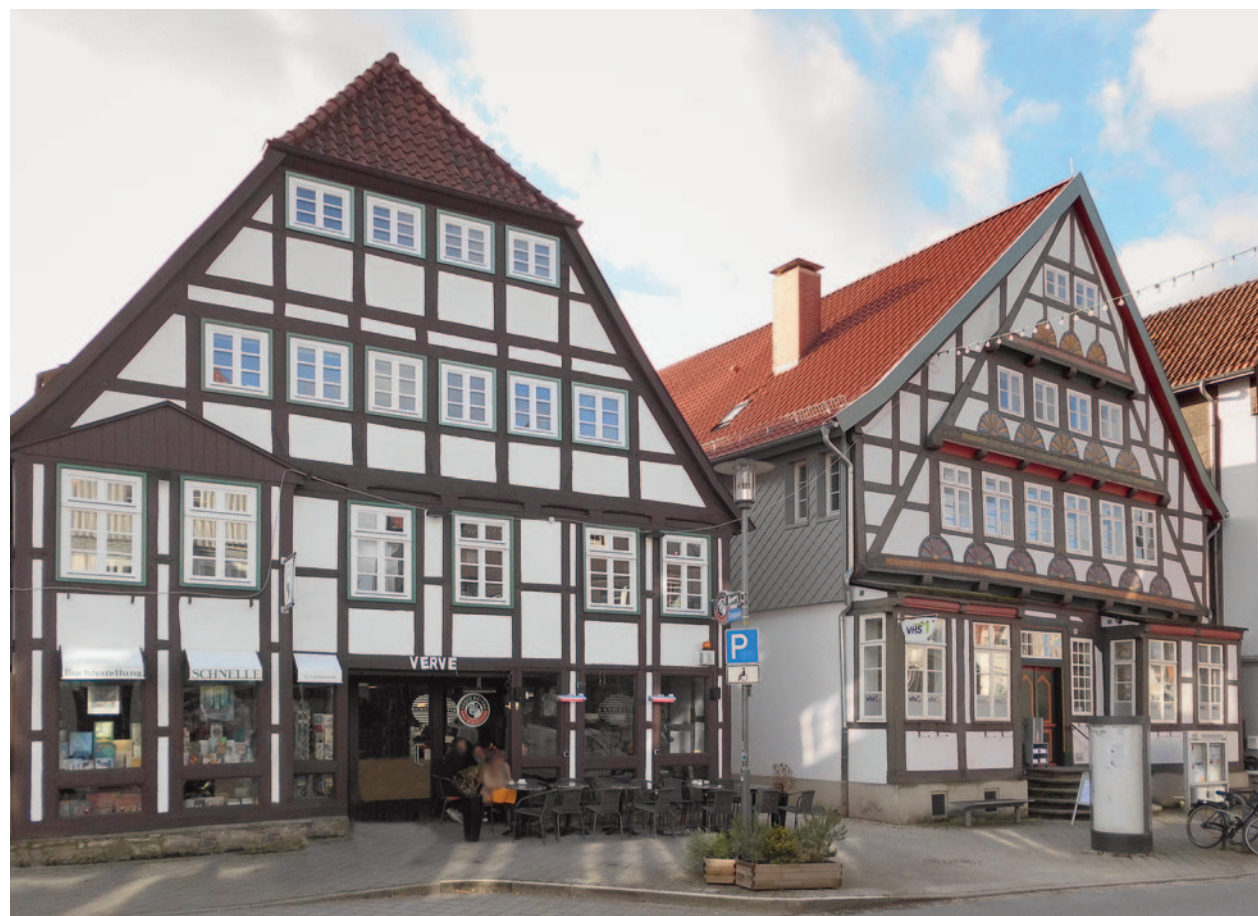
Abb. 313 Krumme Straße 18 (1573 d) und 20 (1561 d). Die beiden Häuser wurden als dreischiffige Dielenhäuser mit hohen Dielentoren erbaut. Nr. 18 (links) erhielt im 19. Jahrhundert eine neue Straßenfront mit einigen wiederverwendeten Althölzern und linksseitiger Utlucht, Nr. 20 (rechts) erhielt 1757 (d) ein aufgesetztes Obergeschoss und zwei Utluchten vor der Fassade (Foto 2015).
