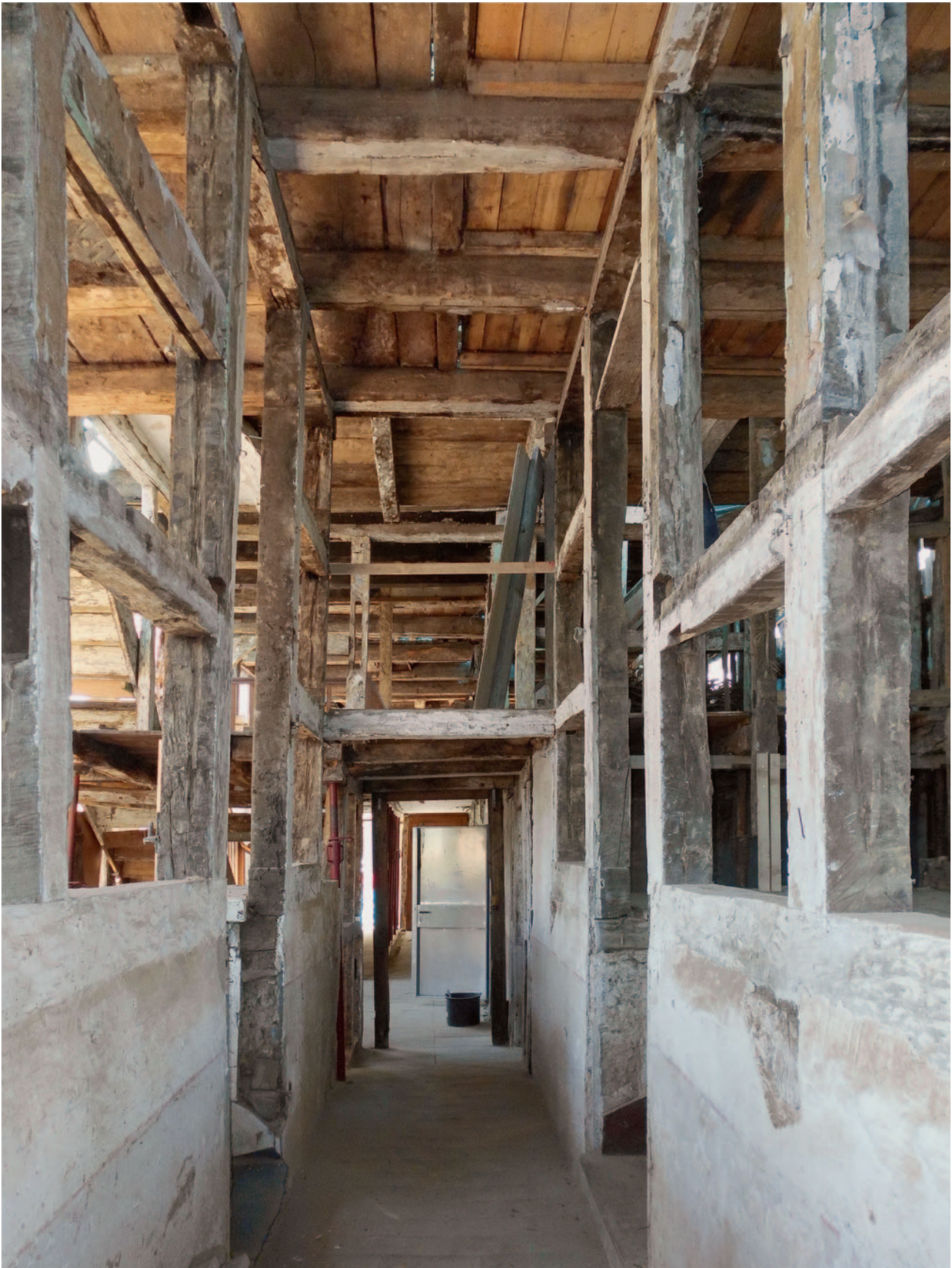
Abb. 286 Exterstraße 16, 1599 (d), Hinterhaus, um 1842 (d). Hoher Mittelflur im Hinterhaus mit Blick zum Vorderhaus. Rechts und links des Flures lagen unterkellerte Wohnräume, darüber befand sich eine zweite Wohntage (Foto in entkerntem Zustand 2018).
