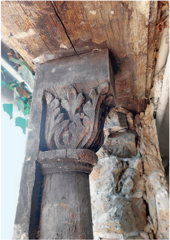
Abb. 285 Exterstraße 16, 1599 (d). Mittelpfosten mit Blattkapitell eines großen Fensters im Bereich der früheren Küchenlucht in der rechten Traufwand, um 1600 (Foto nach Freilegung 2018).
