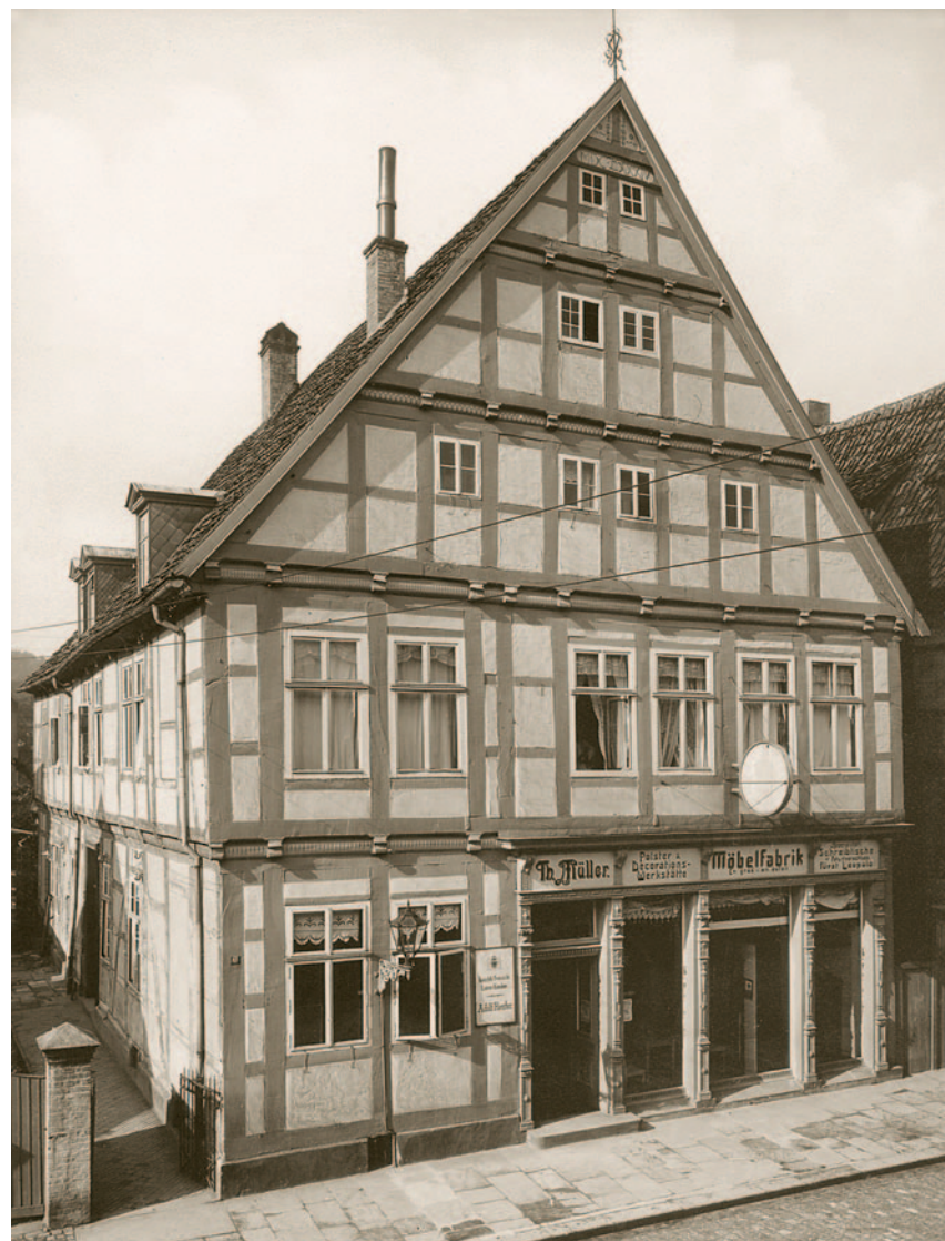
Abb. 196 Exterstraße 11, 1684 (i). Straßenseite nach dem Umbau von 1891, Fotografie von F. Düstersiek. In dem Fluretagenhaus wurde für den Möbelfabrikanten Theodor Müller rechts eine Polster- und Dekorationswerkstatt mit historischer Schaufensterfront eingerichtet, für den der ursprüngliche Mittelflur mit vorderer Freitreppe und die rechte Stube umgebaut wurden. Der Sohn Fritz Müller gründete 1911 die Lampenfabrik „Temde“ außerhalb der Altstadt in Bahnhofsnähe (LLB, HSA 6, 339).
