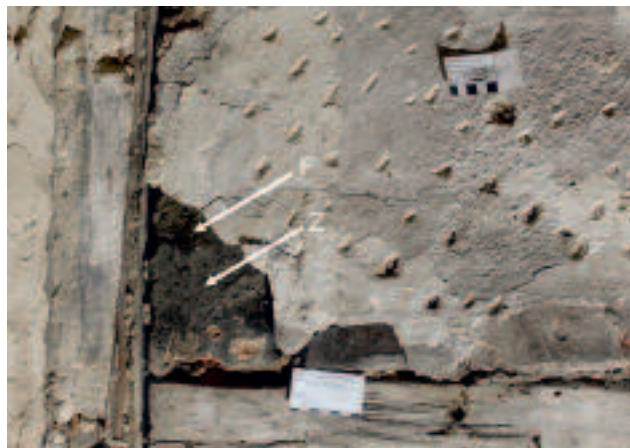
Abb. 8: Haupthaus, Obergeschoss, bauzeitliches Ziegelgefach in der Westwand von Raum 1.04: rußverfärbte Ziegel (Z) und Fugenmörtel (F). Foto: Denis Breitreutz, 2020.
