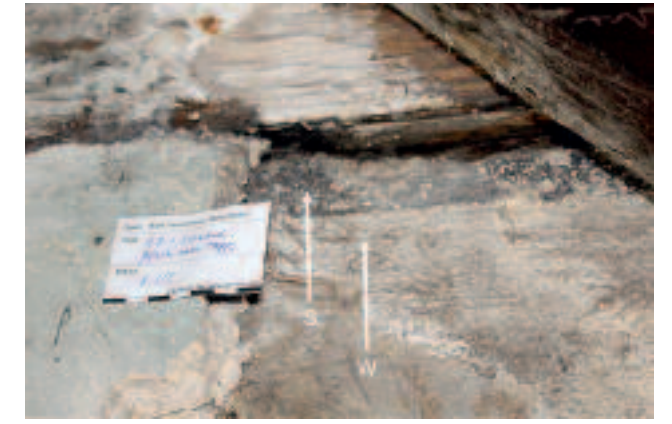
Abb. 11: Haupthaus, Erdgeschoss, Ostwand von Raum 0.1, Lehmgefach unter der Treppe: Reste eines dünnen Kalkputzes auf gekämmtem Lehmewurf mit Weißfassung (W) und schwarzem Begleitstrich (S), Entstehung vermutlich 1711. Foto: Denis Breitreutz, 2020.
