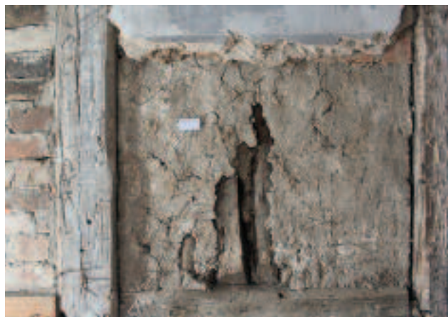
Abb. 9: Haupthaus, Obergeschoss, Lehmstakengefach in der Nordwand von Raum 1.05: rautenförmige Kammritzung auf Lehmewurf mit Resten einer Weißfassung, Entstehung vermutlich 1711. Foto: Denis Breitreutz, 2020.
