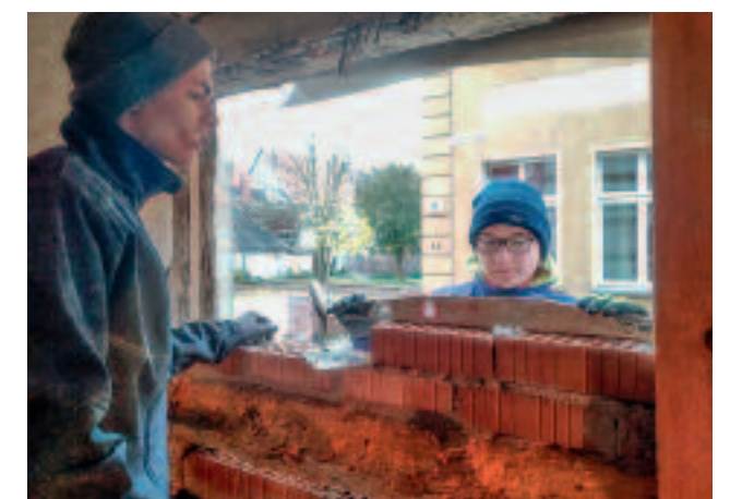
Abb. 4: Konstantin und Ute beim Ausmauern der Gefache. Foto: Bernd Henning, JBH, April 2020.
