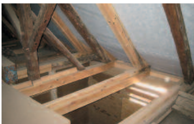
Abb. 5: Durch Austausch von Hölzern reparierte Knotenpunkte zwischen Dachbalken (auch Binder- oder Deckenbalken) und Sparrenfüßen, überdeckt mit kurzen Aufschieblingen zur Herstellung der korrekten Dachneigung. Auch das Wandrähm, auf dem die Dachbalken aufliegen, musste erneuert werden. Foto: Jens Bethge, Krekeler Architekten-Generalplaner, April 2021.
