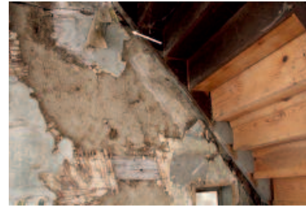
Abb. 10: Haupthaus, Erdgeschoss, Ostwand von Raum 0.1, Lehmgefach unter der Treppe: Reste eines dünnen Kalkputzes auf gekämmtem Lehmewurf mit Weißfassung und schwarzem Begleitstrich, Entstehung vermutlich 1711. Foto: Denis Breitreutz, 2020.
