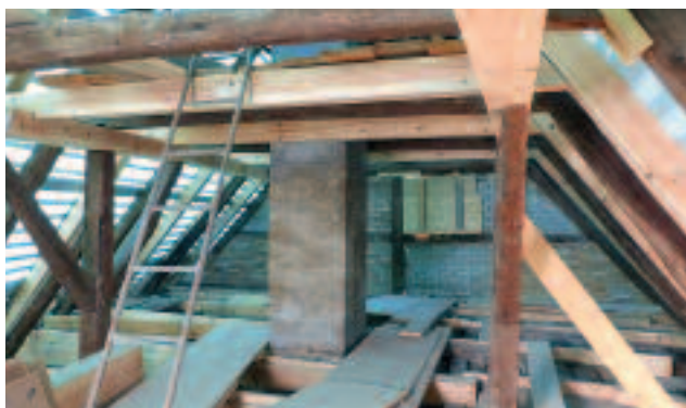
Abb. 4: Blick ins Dachgeschoss Richtung Hofseite (Norden) nach der Sanierung mit erneuerten Stuhlrähmen und ausgetauschten Zwischenbinden. Foto: Bernd Henning, JBH, Dezember 2020.
