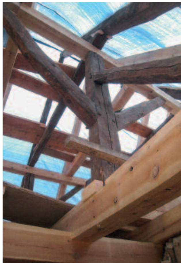
Abb. 6: Blick vom Obergeschoss zwischen den erneuerten Dachbalken hindurch auf einen der Stuhlverbände mit Stuhlständer (auch Stuhlsäule) mit seitlich eingezapften Kopfbändern und darüber verlaufendem ausgetauschten Stuhlrähm. Am Stuhlständer ist ein eingekerbtes Abbundzeichen erkennbar. Rechts unterhalb des Sparrens befindet sich eine zusätzlich queraussteifende Strebe. Foto: Jens Bethge, Krekeler Architekten-Generalplaner, Oktober 2020.
