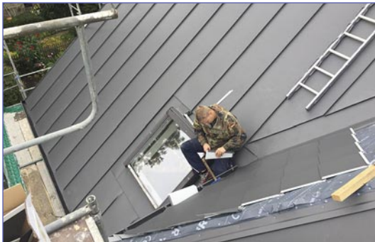
Bild 1: Dach- und Fassadengestalter bei der Arbeit
