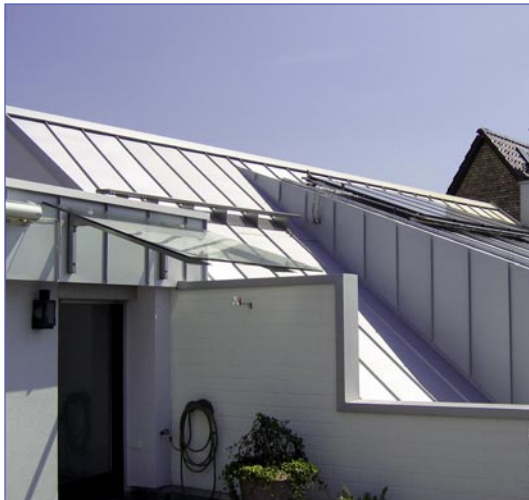
Bild 1: Titanzinkdach walzblank
