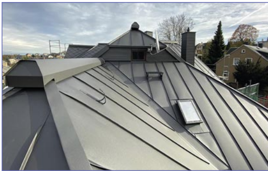
Bild 2: Dacheindeckung mit Prefa
