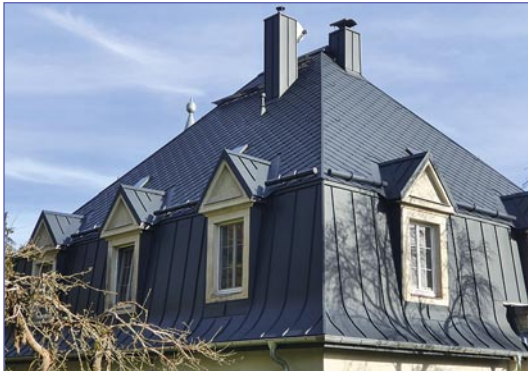
Bild 1: Umfangreiche Dachsanierung mit Raute und Stehfalz
