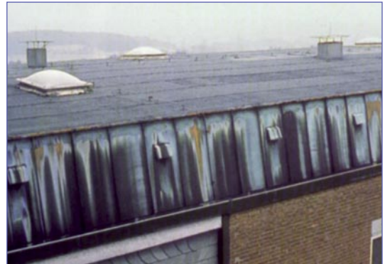
Bild 2: Kupferfärbungen infolge Bitumensäure-Einwirkung.
