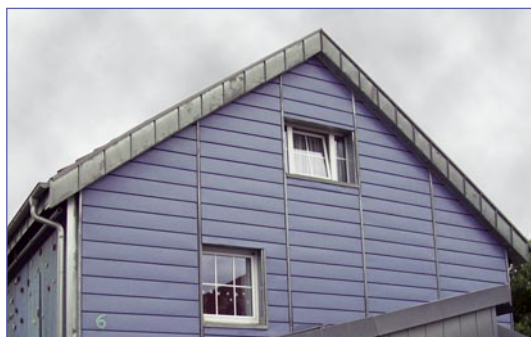
Bild 5: Die Wetterseite – Farbaluminium mit senkrechten Titanzinklisenen
