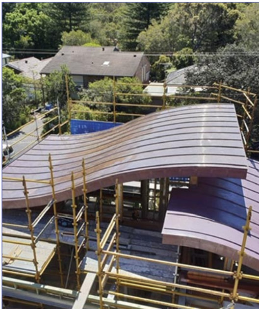
Bild 1: Dacheindeckung aus Kupfer
