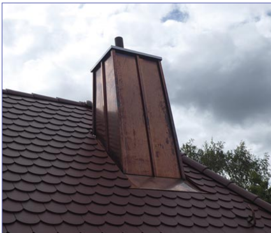
Bild 2: Einfärbungen von Kupfer von braun zu schwarz
