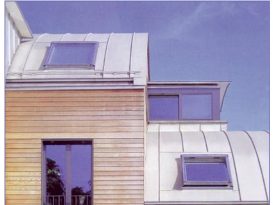
Bild 2: Falzinc in Fassade und Dachbereich
