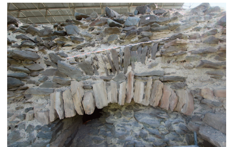
Abb. 12 (links unten) Mildenfurth, Stiftskirche, Westbau, Südturm, Erdgeschoss, Westwand von Osten, sekundär vermauerte Laibungsnische des Okulus, Befund-Nr. 16, 2019
