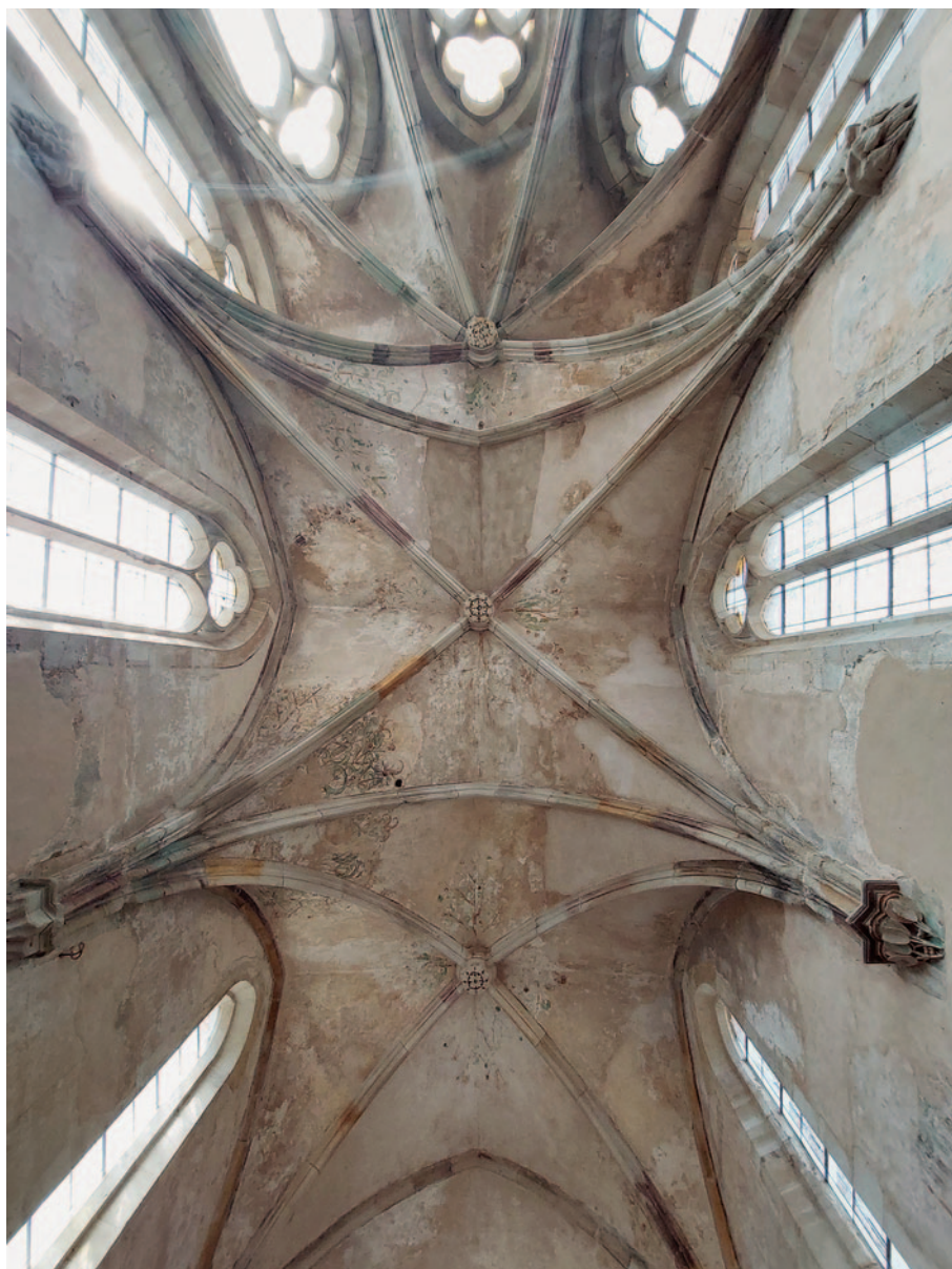
Abb. 2: Das gotische Kreuzrippengewölbe der Templarkapelle.
