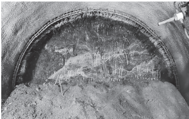
Bild 15. Ortsbrust der Kalotte im Bergsturz mit Ausbruchmaterial
