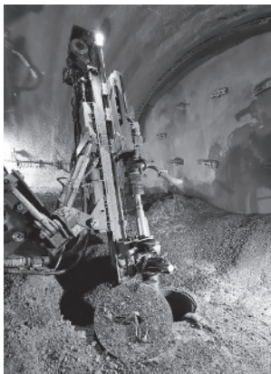
Bild 12. Bohren eines Vertikalfilterbrunnens
