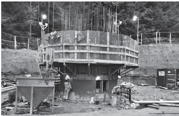
Bild 27. Gleitschalung zur Herstellung des Abluftkamins
