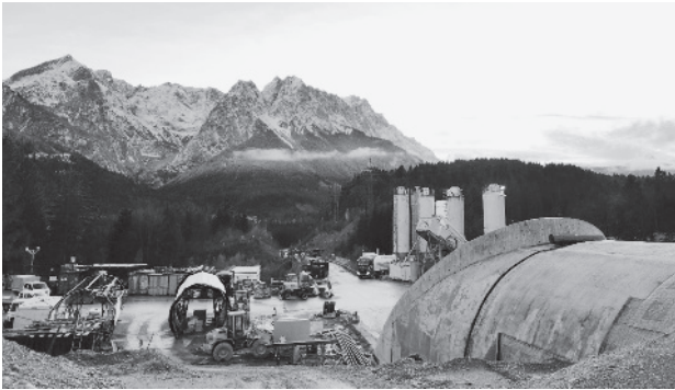
Bild 30. Südportal mit Wettersteinmassiv
