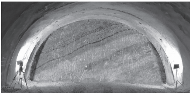
Bild 5. Ortsbrustfoto bei Tunnelmeter 2877,6 im gut geschichteten Hauptdolomit
