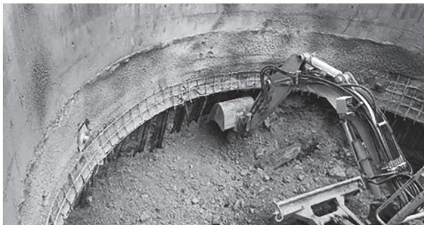
Bild 23. Abteufen im Lockergestein im Schutz der Spunddielen
