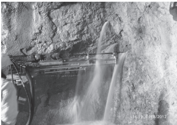
Bild 20. Vortrieb Erkundungsstollen im Hauptdolomit
