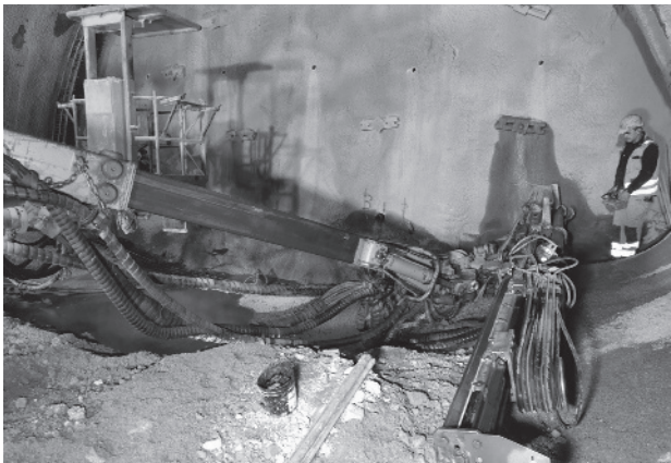
Bild 13. Steigende Drainagebohrung im Querschnitt mit dem Vortriebsbohrwagen
