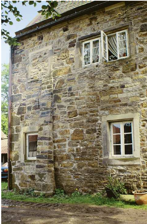
178 | Rittergut Remeringhausen, Schlösschen, Strebepfeiler an der Hoffassade
