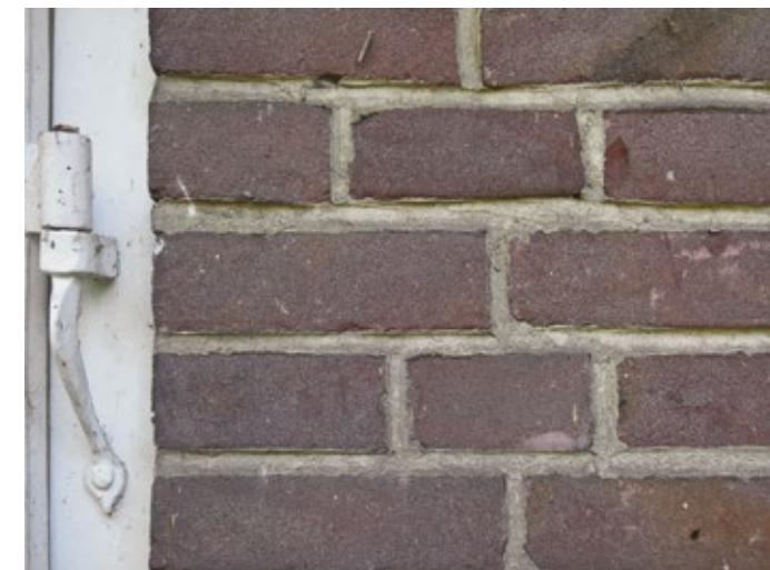
5 Putzfugen und Schmiedearbeiten von Wilhelm Büning am Bungalow, 2023
