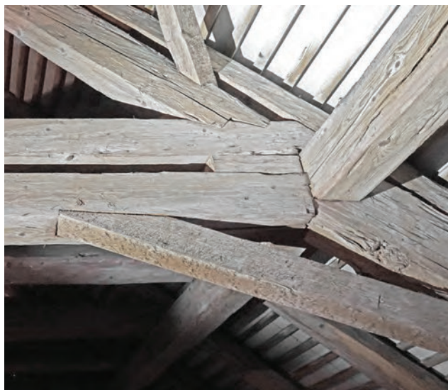
119 oben Bindergespärre der Dachkonstruktion von Bauma ZH.
