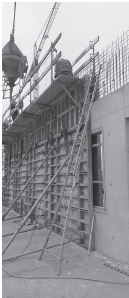
Abb. 1 Unsichere und gefährdende Baustelleneinrichtung: das Gerüst und der Aufstieg sind ungeeignet
