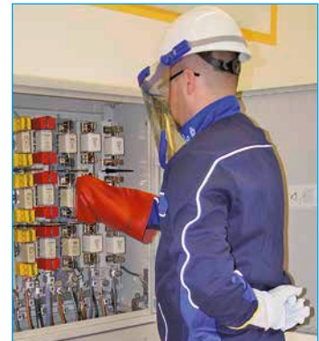
Bild 2: Elektrofachkraft beim Ziehen eines NH-Sicherungseinsatzes
