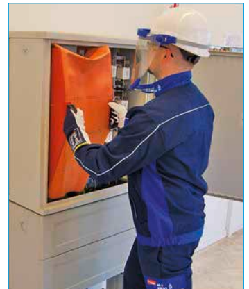
Bild 2: Abdecken spannungsführender Teile
