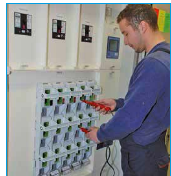
Bild 4: Überprüfen der Spannungsfreiheit mit einem zwei-poligen Spannungsprüfer
