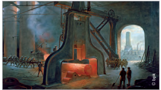
Bild 1: Dampfhammer (1839) von James Nasmyth 1
