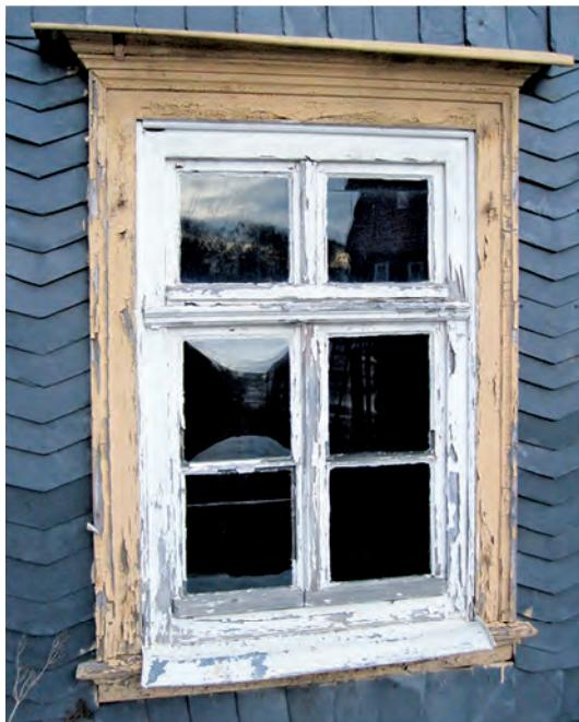
9. Der Rahmen ist beispielsweise durch das Scheibengewicht und die Windlast großen mechanischen Belastungen ausgesetzt.
