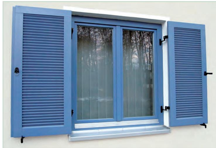
2. Fensterprofile bestehen entweder aus Holz, Aluminiumlegierungen oder PVC-U. Den größten Marktanteil nimmt zur Zeit PVC-U mit über 50 % ein.
