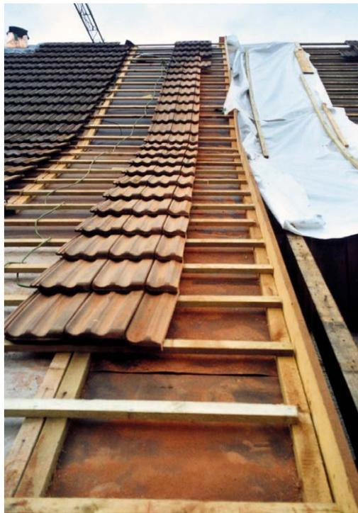
*Das Unterdach ist durchgängig regensicher auszuführen. Die Hinterlüftungsebene sollte 4–5 cm hoch sein, damit der offene Querschnitt nicht durch Schutzgitter zu sehr reduziert wird [A (links); B1 (rechts)].*
