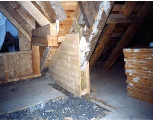
*Wichtige lastabtragende Fußpunkte können mit Dreischichtplatten gesichert werden. Schadhafte, aber erhaltensfähige Bauteile können so auch überbrückt werden. Die statischen Maßnahmen sind zusammen mit einem Statiker anzuordnen und abzunehmen [B1].*
