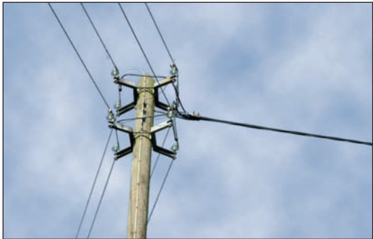
Bild 2: Vierleiternetz für 400 V
