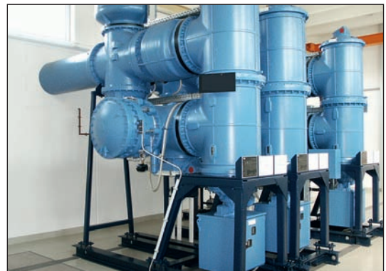
Bild 4: Gasisolierte \text{SF}_6 -Schaltanlage
