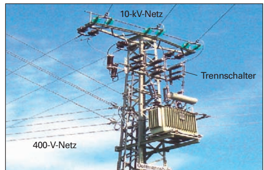
Bild 3: Maststation
