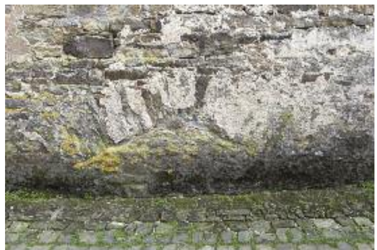
69b: Wie Abb. 69a: Nord-Tür – 1.N2 (vermauert und fast völlig zugeschüttet; vgl. JE20, Pl. 21) mit Giebelbogensturz(?), von N [2011 (JE)]
