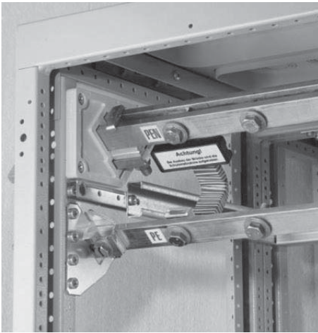
Bild 8.4.3.2.3-7 Beispiel einer Ausführung für den zentralen Erdungspunkt Quelle: Gustav Hensel GmbH & Co. KG
