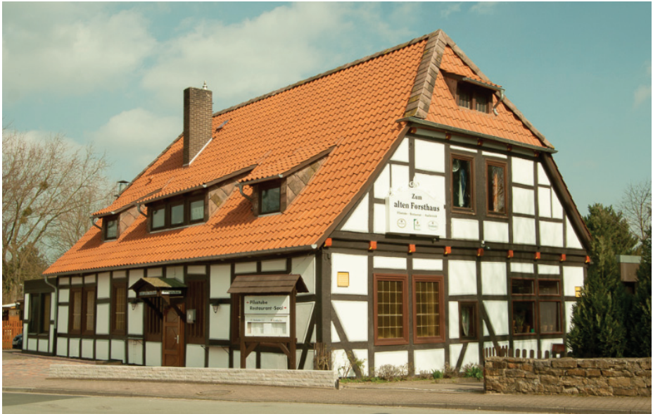
Abb. 1: Das 1744 erbaute Wohn- und Amtshaus von Oberförster Dieterich Eberhard Kuntze, heute Gaststätte »Zum alten Forsthaus« in 31855 Aerzen, Tannenweg 8 (Foto: Ewald Stubel, Aerzen, Bild-Nr. 16828 vom 28.03.2015).
