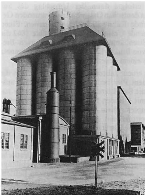
Bild 1-13 Getreidesilo aus 12 zylindrischen Blechsilos System J. A. Topf & Söhne, Erfurt
