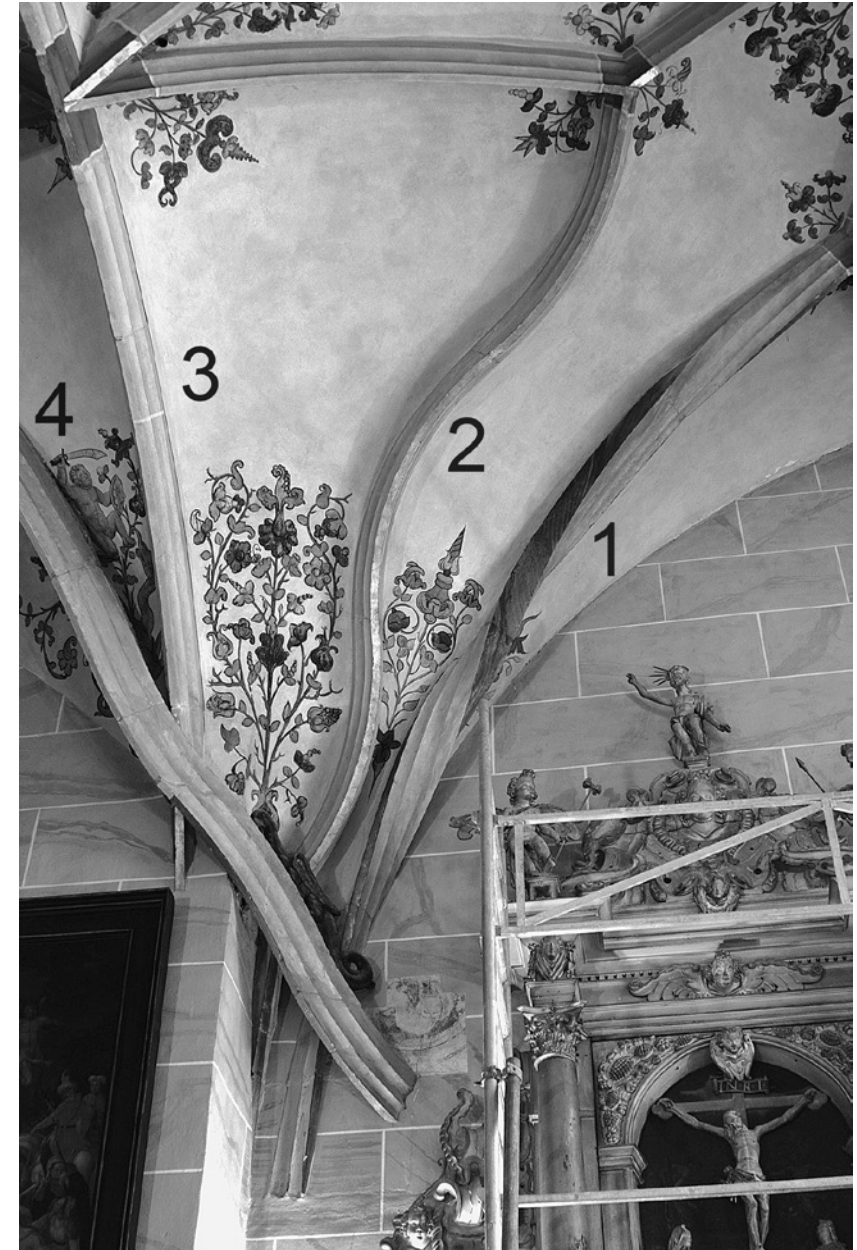
Abb. 5 Pirna, Marienkirche, Westwand, Gewölbeanfänger in einem unregelmäßigen Wandanschluss mit musterhaft ausgebildeten Rillenverläufen gemäß abnehmender Form- und Bearbeitungsintensität: 1 tordiert, 2 gewunden, 3 scheitrecht; Rippe 4 als gewellte Linie und Weg des geflügelten Drachens
