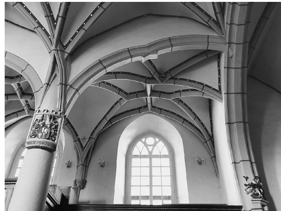
Abb. 3 Dohna, Marienkirche, östliche Nordarkade, Scheidbogen mit diskontinuierlichem Verlauf; sowohl die Einbindung des Bogens in den Chorbogen als auch der Bruch des Bogens wird durch sogenannte ›durchschlüpfende Schenkel‹ samt gekappten Endungen sichtbar gemacht; unmittelbar hinter dem Bruch befindet sich im Rippengewölbe eine auf einer Wolke schwebende Muttergottes mit Kind; den Fußpunkt der Konstruktion bildet die feste Wappentafel des Stifters Günter von Bünau
