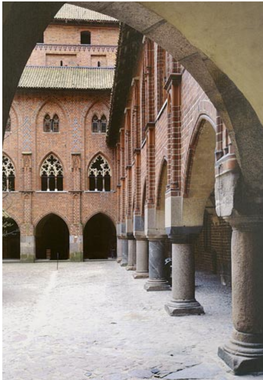
ABB. 51 Marienburg, Hochschloss, Ansicht des westlichen und südlichen Kreuzgangsarmes von der Toreinfahrt aus
