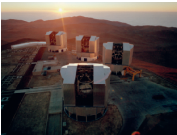
Abb. 2: Das Very Large Telescope (VLT) der Europäischen Südsternwarte (ESO) auf dem 2635 Meter hohen Cerro Paranal in der Atacamawüste im Norden Chiles ist eines der größten und leistungsfähigsten Spiegelteleskope der Welt. Die vier gleichartigen Teleskope, jedes mit einem Spiegeldurchmesser von 8,2 Metern, können sowohl einzeln benutzt werden als auch über entsprechende Strahlführungen zu einem einzigen Teleskop zusammengeschaltet werden.
