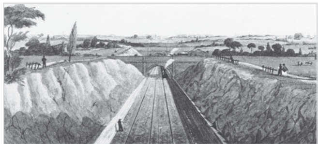
Bild 2: Liverpool–Manchester: Gestreckte Linienführung, flache Streckenneigung, zweigleisige Strecke, schienenfreie Kreuzungen, Personen- und Güterverkehr
