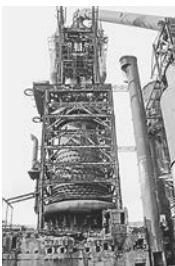
Die \_\_\_\_\_ erfolgt über einen Schrägaufzug von oben in die Glocke, abwechselnd mit \_\_\_\_\_ und Möller. \_\_\_\_\_ wird von unten über eine Ringleitung eingeblasen und steigt nach oben. Die unterste Koksschicht verbrennt in der \_\_\_\_\_ mit Sauerstoff zu \_\_\_\_\_. Dieses reagiert mit der darüberliegenden Koksschicht zu Kohlenstoffmonoxid. Kohlenstoffmonoxid \_\_\_\_\_ das Eisenoxid im Schacht zu Eisen.
