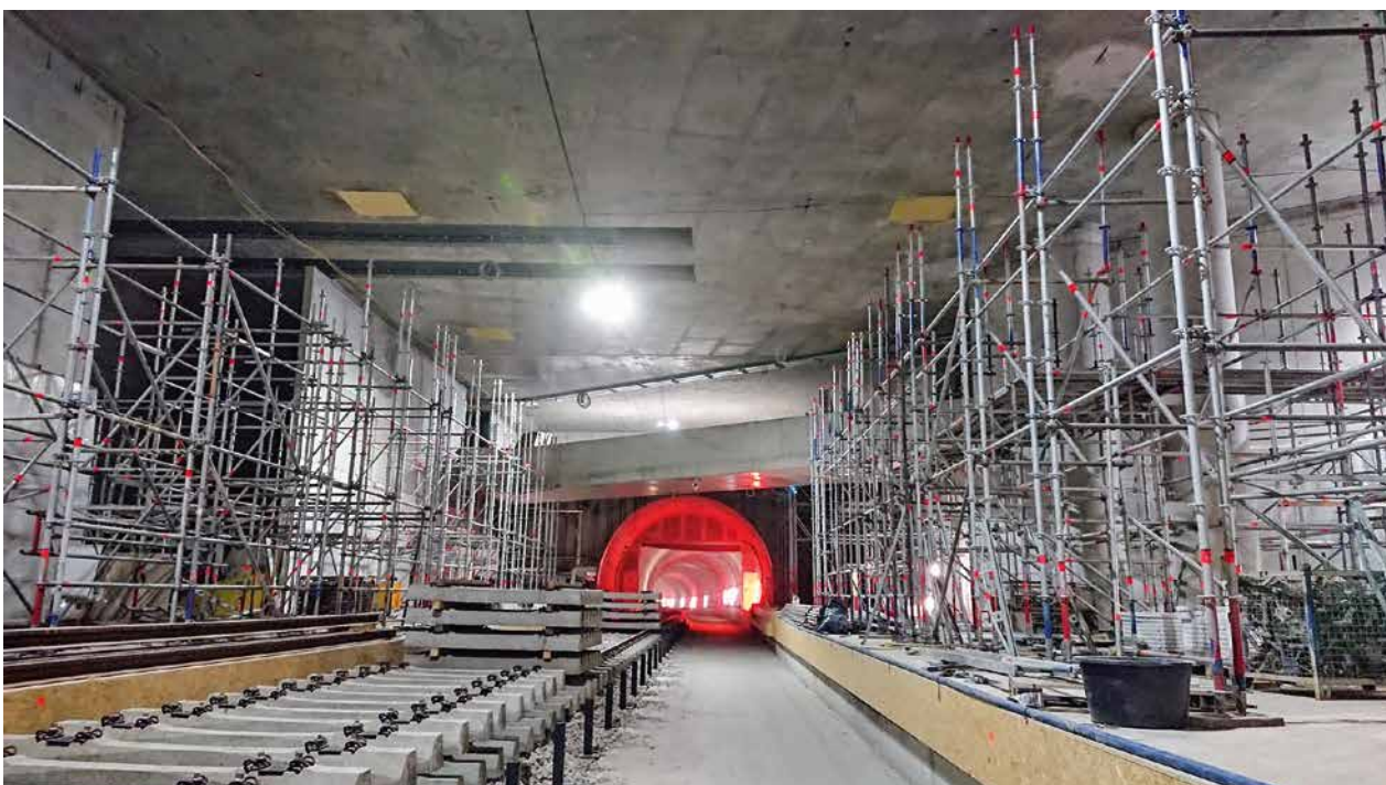
2 Einbau der Bahnschwellen an der Haltestelle Durlacher Tor West und Aufbau des Raumgerüsts für den Trockenbau der Abhangdecke
