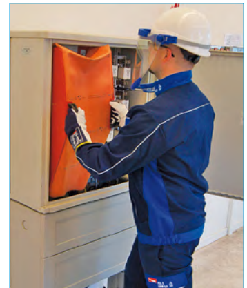
Bild 2: Abdecken spannungsführender Teile
