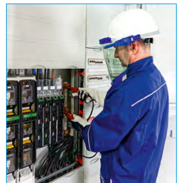
Bild 4: Überprüfen der Spannungsfreiheit mit einem zwei-poligen Spannungsprüfer
