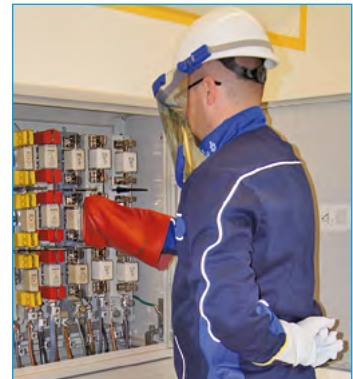
Bild 2: Elektrofachkraft beim Ziehen eines NH-Sicherungseinsatzes
