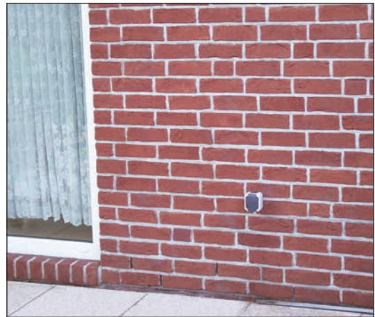
Bild 1: Außensteckdose an der Außenwand
