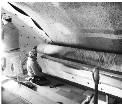
Bild 10. Installation mit einer maschinell geführten Vergetraverse aufgrund des hohen spezifischen Eigengewichts der Bentonitmatten
