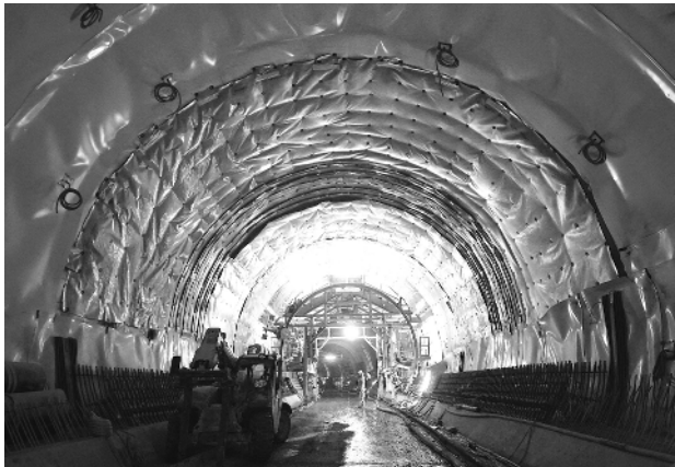
Bild 4. Verpress- und Entlüftungsleitungen im außenliegenden Fugenband
