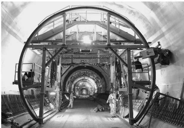
Bild 8. Doppellagige Druckwasserabdichtung als Mehrkomponentensystem mit Bentonitmatten
