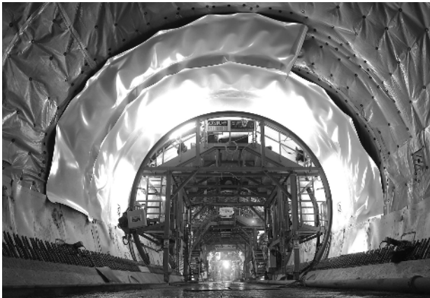
Bild 7. Im Gewölbe eingebaute Bentonitmatte
