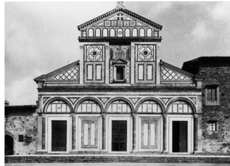
2 ► San Miniato al Monte in Florenz. Fassade, spätes 11. bis 12. Jahrhundert. ► San Miniato al Monte in Florenz. Façade, late 11th to 12th century.
