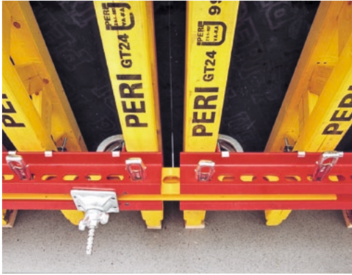
Bild 5.2 Elementstoß einer Holzträgerschalung, Bildquelle: PERI
