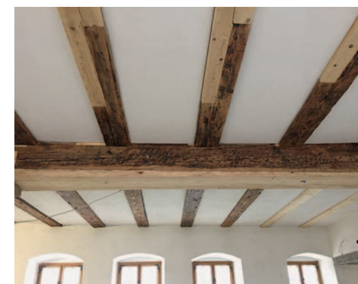
Südflügel, Decke mit alten und ergänzten Balken
