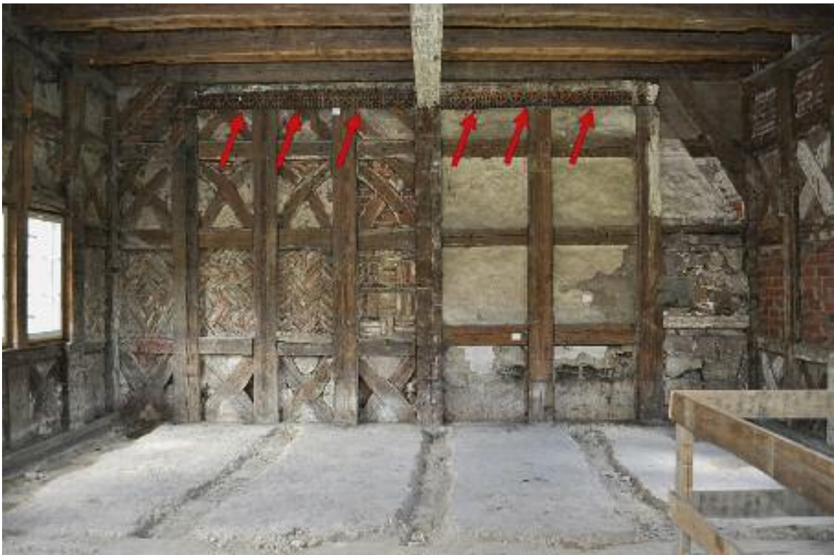
9 Erdgeschoss Nordgie-bel, Innenansicht: der Nordgiebel nach der Ab-nahme einer Verkleidung mit zementgebundenen Holz-faserplatten. Die Holzoberflächen und die Ausfachungen waren in einem sehr guten Erhal-tungszustand. Im oberen Wandabschluss ein Brett mit Schablonierung als Hinweis auf einen vormals trapezförmigen Decken-abschluss.
