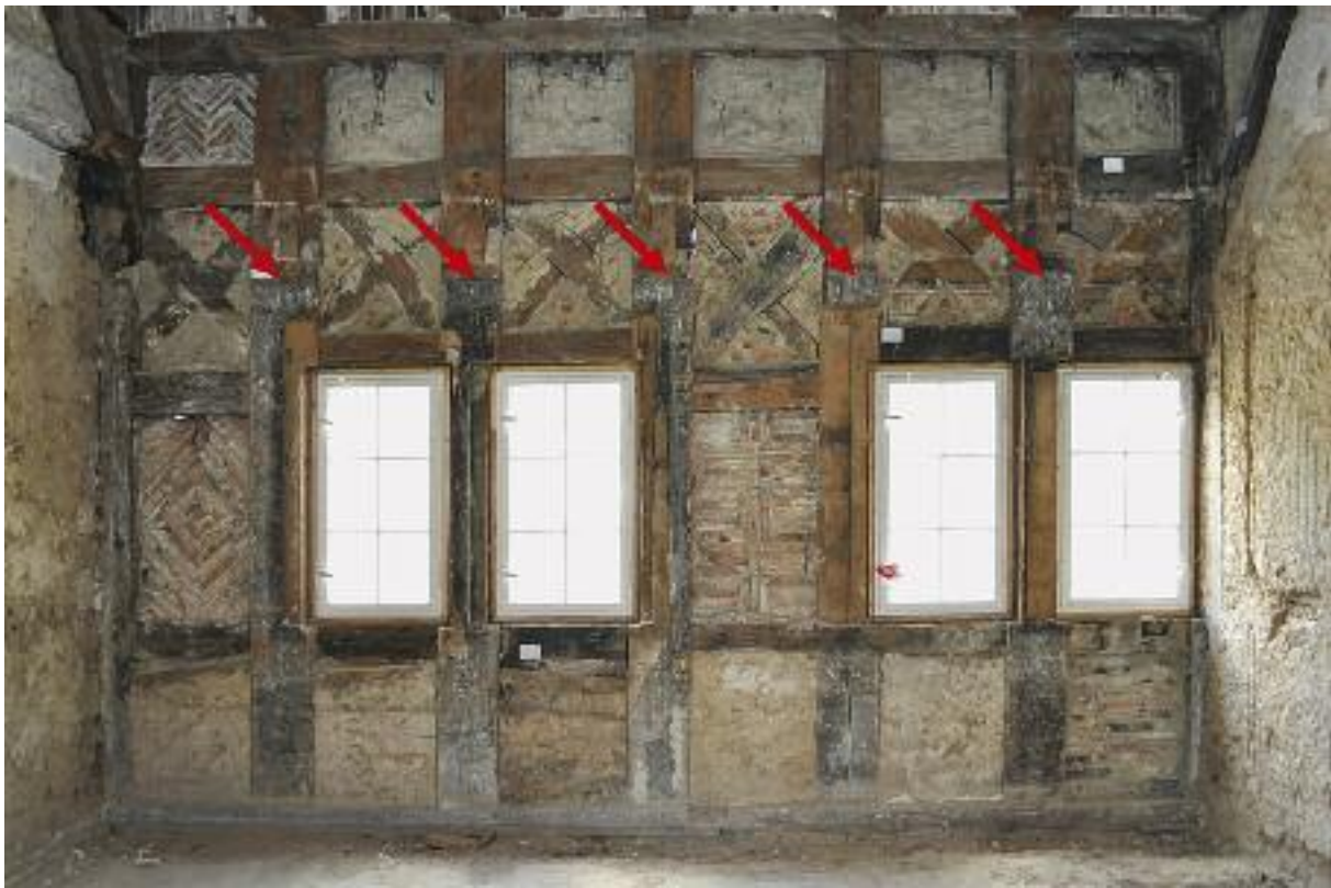
11 Vorsaal zur Stube, Blick auf die westliche Fachwerkaußenwand: das Fachwerk auch auf der Innenseite in einer Schwarzweißfassung mit Begleitstrich und Ritzer. Die Fassungs-grenze liegt im Anschluss der Kopf-bänder an die Fachwerk-ständer und verweist in diesem Raum auch auf einen nach oben trapez-förmigen Raumabschluss.
