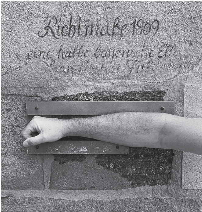
Abbildung 1.1: Eine halbe bayrische Elle (oberes Metallband) und ein bayrischer Fuß (unteres Metallband) aus dem Jahre 1809 am Rathaus in Schwabach. Im Vergleich dazu die Unterarmlänge des Autors.
