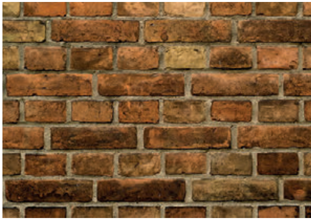
454 Kreuzverband bei den Veltener Vollformatverblendern an der Kirche St.-Jacobi in Berlin, Stüler, 1844–1845.
