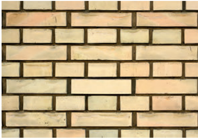
455 Blockverband aus vertikal gepressten Maschinensteinen an den ehemaligen Chemischen Laboratorien in Zürich, Bluntschli & Lasius, 1884–1886.
