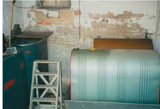
Alter Öltank in feuchtem Keller
