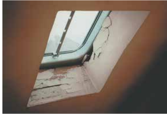
Undichtes Dachflächenfenster
