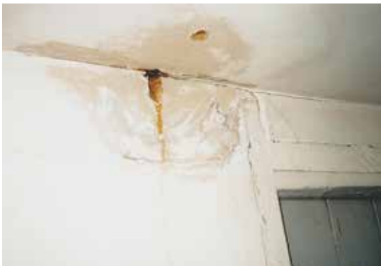
Feuchteschaden im Dachraum
