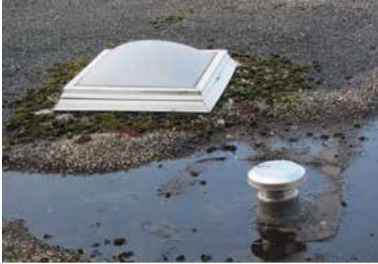
Sanierungsbedürftiges Flachdach
