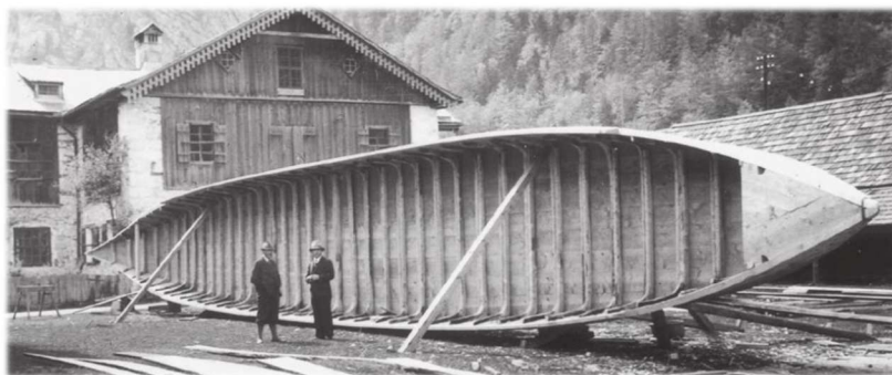
Eine eben fertiggestellte „Siebnerin“ für den Salztransport. Dies Schiffe hatten eine Länge von bis zu 36 Metern und waren 3,3 Meter breit, bei einem Tiefgang von 70 cm. Beladen werden konnten sie mit bis zu 54 Tonnen Salz.
