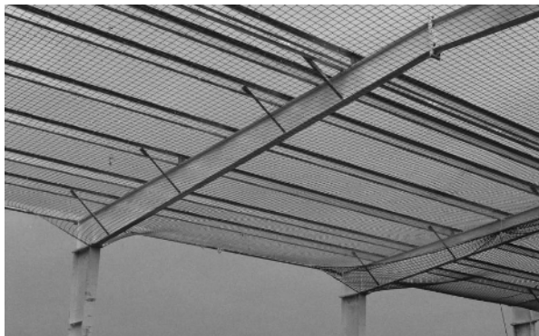
Bild 1.7 Dachpfetten, Schrägstreben und Rahmenriegel
