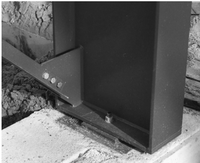
Bild 1.5 Gelenkiger Stützenfuß
