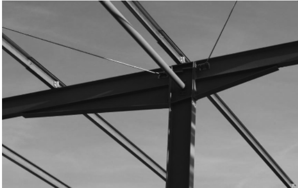
Bild 1.12 Mittelstütze mit Rahmenecken
