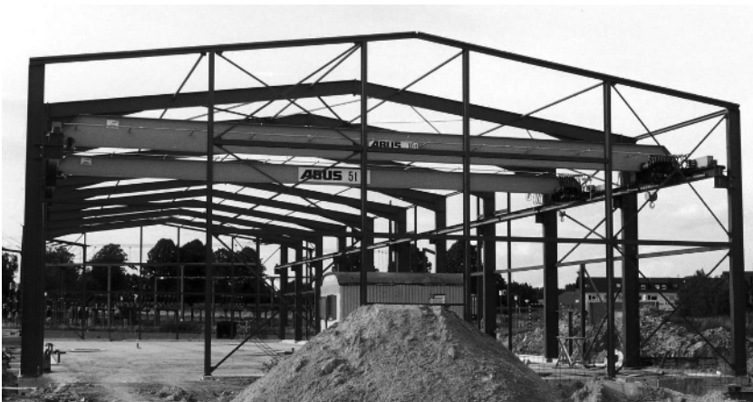
Bild 1.2 Giebelwandkonstruktion
