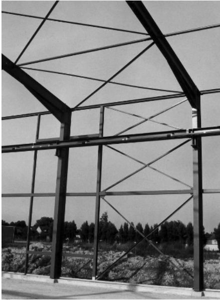
Bild 1.3 Wand- und Dachverband
