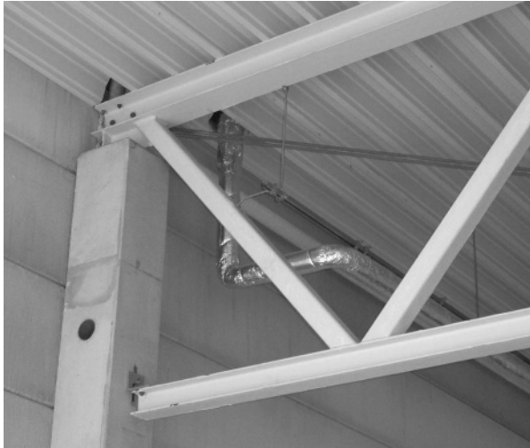
Bild 1.15 Auflagerdetail eines Fachwerkbinders
