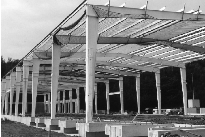
Bild 1.6 Geschweißte Zweigelenkrahmen einer Lagerhalle
