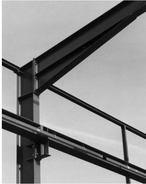
Bild 1.4 Rahmenecke mit Voute und Kranbahnträger
