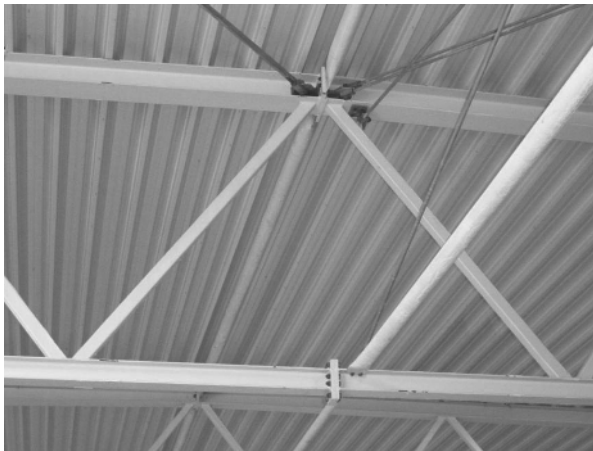
Bild 1.16 Detail Fachwerkbinder mit Stahltrapezblechen
