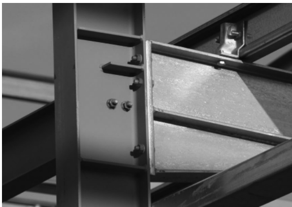
Bild 1.11 Geschraubte Rahmenecke
