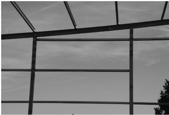
Bild 1.13 Giebelwandkonstruktion
