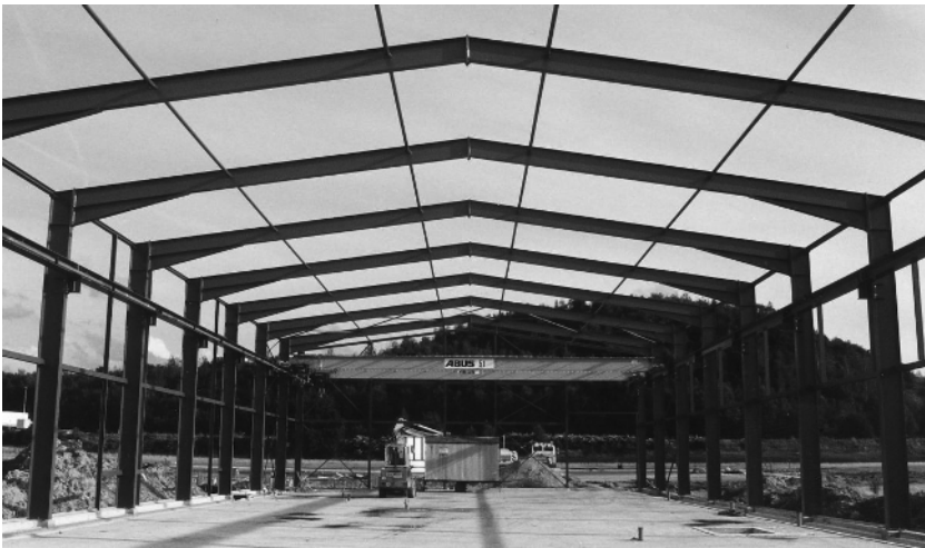
Bild 1.1 Zweigelenkrahmen einer Fertigungshalle aus Walzprofilen
