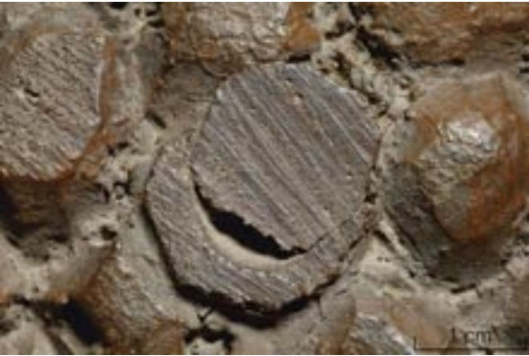
21 | Goldene Tafel, hl. Johannes d. T., Kopfoberseite mit zweifach ausgeführter Bohrung und Haltestangen.
