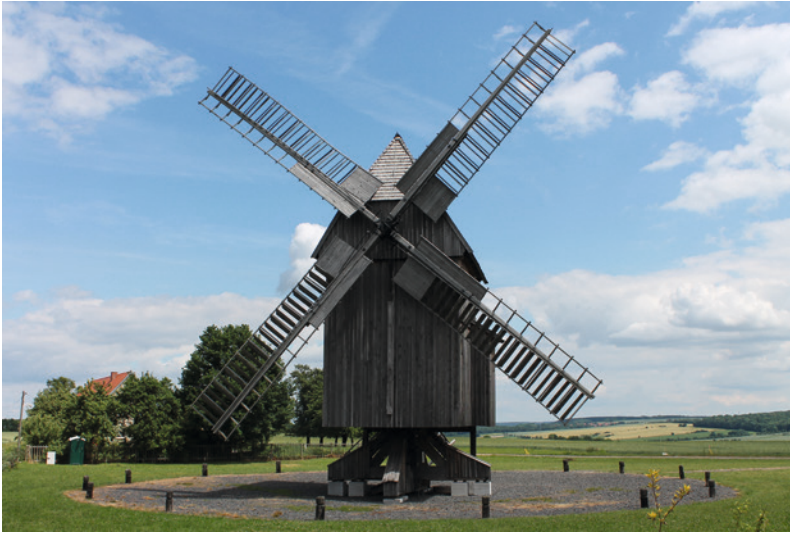
Bild 1.2 Bockwindmühle (© Wikipedia, User: indeedous)
