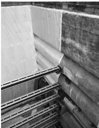
Bild 33. Zentraler Zugang, Technikgebäude West, Abdichtungsarbeiten
