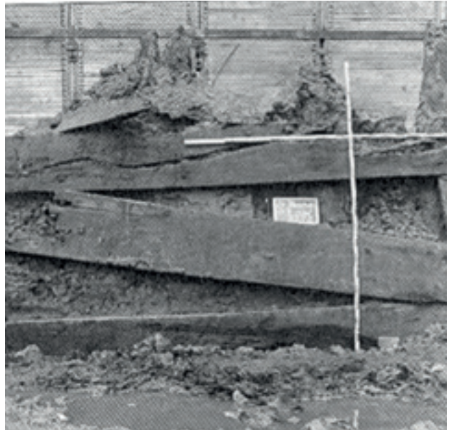
Hölzerne Uferbefestigung in einer Baugrube der Tiefgarage Osterdeich / Bleicherstraße
