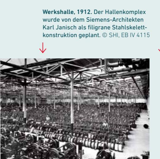
Werkshalle, 1912. Der Hallenkomplex wurde von dem Siemens-Architekten Karl Janisch als filigrane Stahlskelettkonstruktion geplant. © SHI, EB IV 4115
