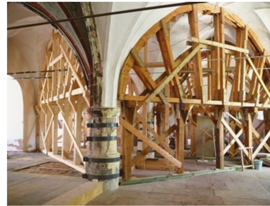
Abb. 5 Sondershausen, Schloss Sondershausen, Alter Nordflügel, Sterngewölbe mit Lehrgerüsten
