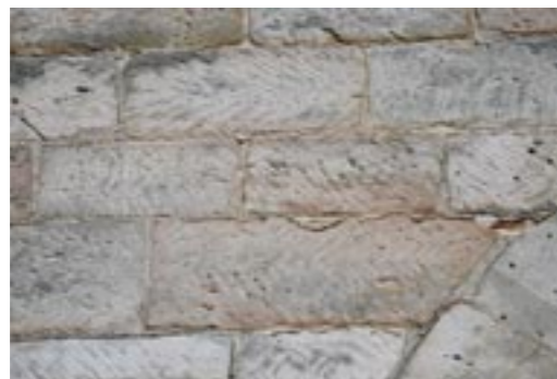
Abb. 5 Paulinzella, Kloster Paulinzella, Kirchenruine, Querhaus, Detail der Ergänzung von Fugenmörteln im Umfeld von gut erhaltenen Bestandsfugen (dunklere Abschnitte mit natürlicher Patina), 2020
