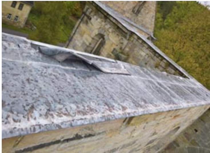
Abb. 3 Paulinzella, Kloster Paulinzella, Kirchenruine, nördliche Langhauswand, geschädigte Mauerkroneabdeckung, 2018
